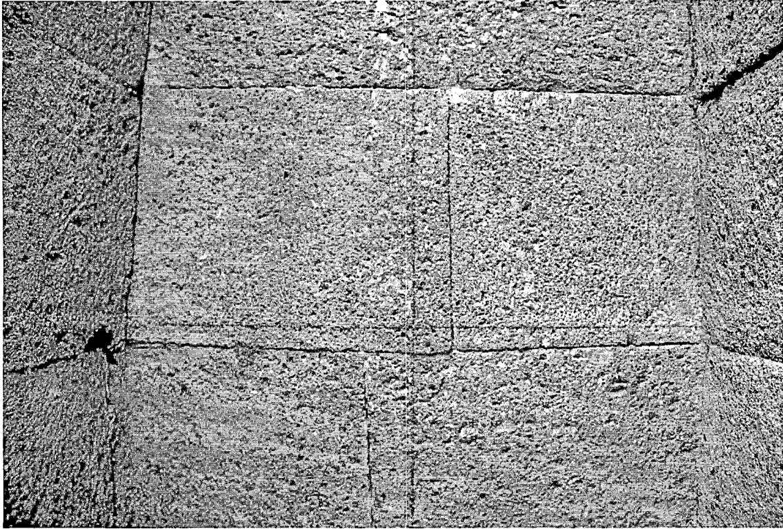
Detalle de muro con piedras labradas con líneas rojas para ensamblar con exactitud el nivel y altura
