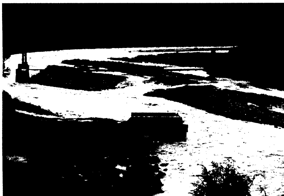
Fotografía 05: Inundacion en el estribo derecho del Puente Huanchuy
