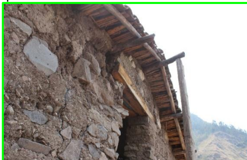
Vigas y listones de la casa a base de especies de plantas de la zona.
