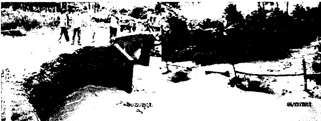
Figura 3.1: Colapso de Alcantarilla en carretera Pichari – Teresa
