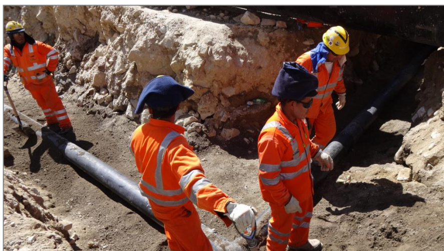
Figura 7. Esperas-descansos. Fuente: Elaboración propia. [Fotografía], Las Bambas: Apurímac. (2015)
