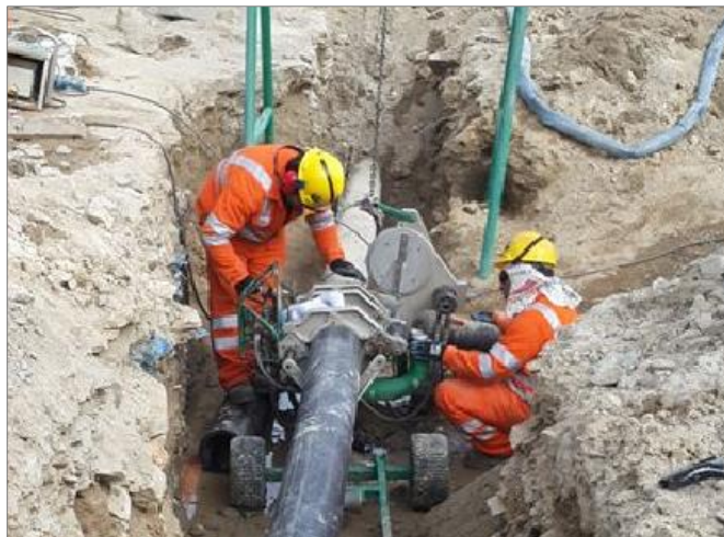
Figura 5. Termofusionado de tubería. Fuente: Elaboración propia. [Fotografía], Las Bambas: Apurímac. (2015)
