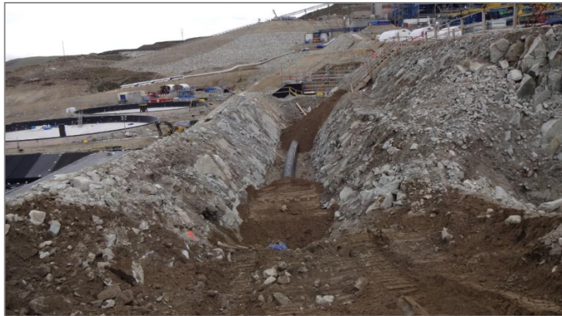
Figura 67. Relleno de la excavación.
