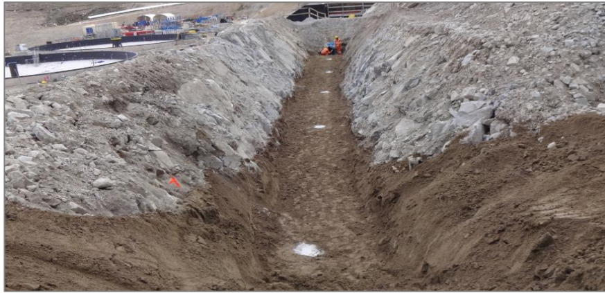
Figura 63. Excavación y control de excavación para instalar la tubería. Fuente: Elaboración propia. [Fotografía], Las Bambas: Apurímac. (2015)
