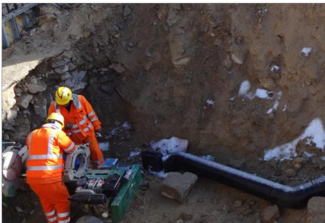
Figura 6. Habilitación de la máquina de termofusión. Fuente: Elaboración propia. [Fotografía], Las Bambas: Apurímac. (2015)
