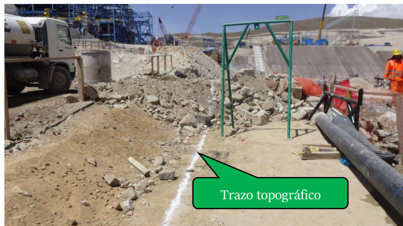
Figura 62. Trazo topográfico de la tubería. Fuente: Elaboración propia. [Fotografía], Las Bambas: Apurímac. (2015)
