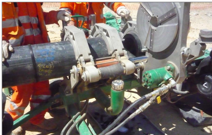
Figura 64. Termofusionado de la tubería. Fuente: Elaboración propia. [Fotografía], Las Bambas: Apurímac. (2015)
