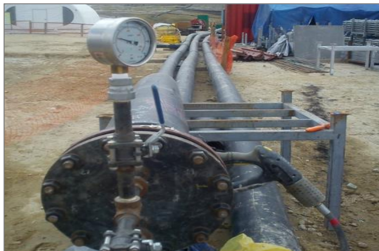
Figura 65. Prueba hidrostática de la tubería termofusionada. Fuente: Elaboración propia. [Fotografía], Las Bambas: Apurímac. (2015)
