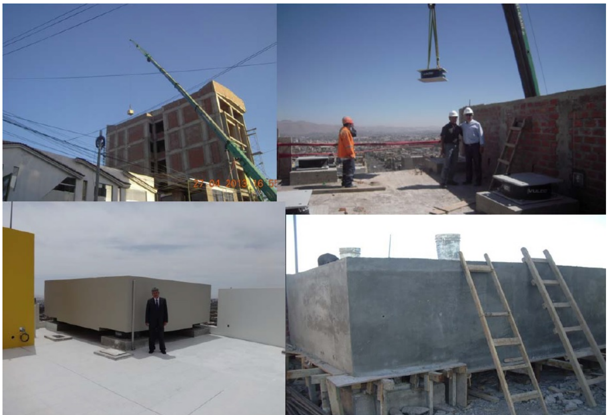
Figura G.4: Instalación de un AMS. Fuente ICG.
