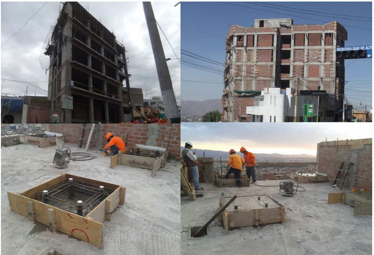
Figura G.3: Proceso constructivo del AMS. Fuente ICG.
