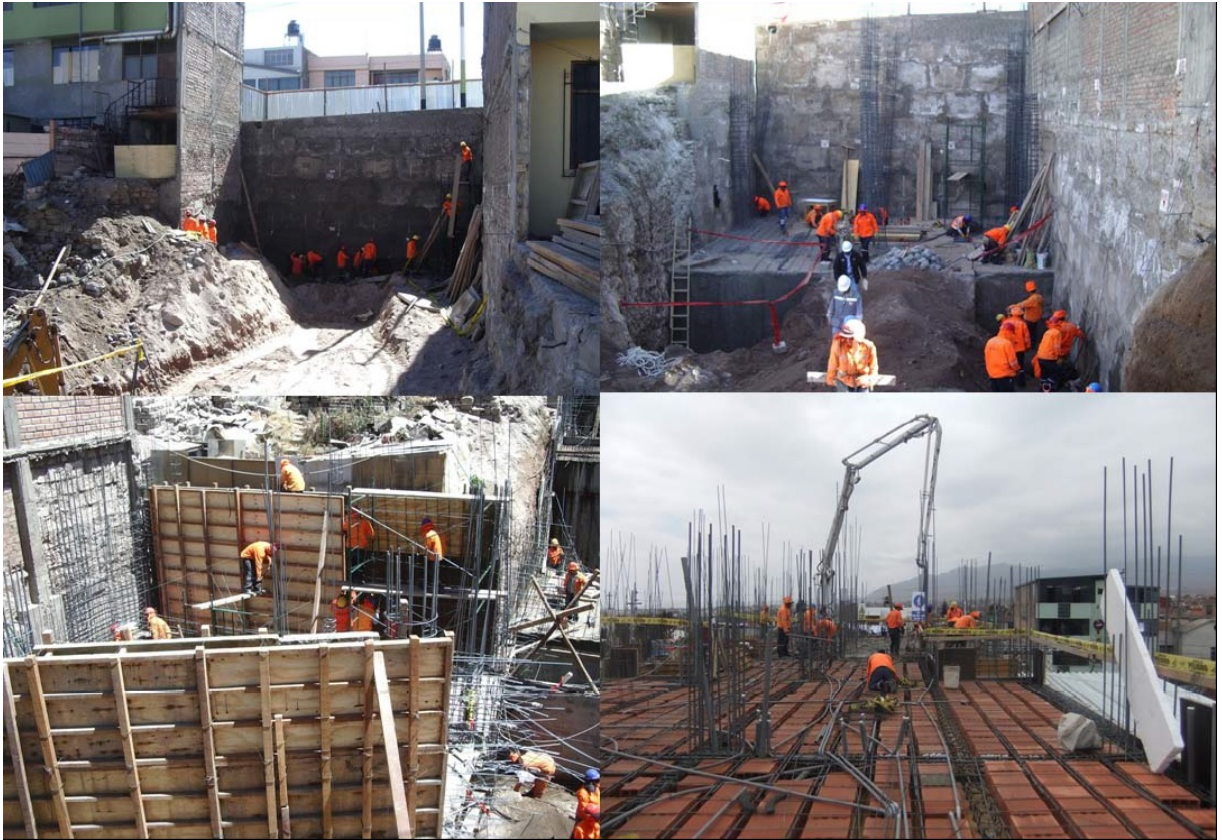
Figura G.2: Proceso constructivo de edificación con AMS. Fuente ICG.
