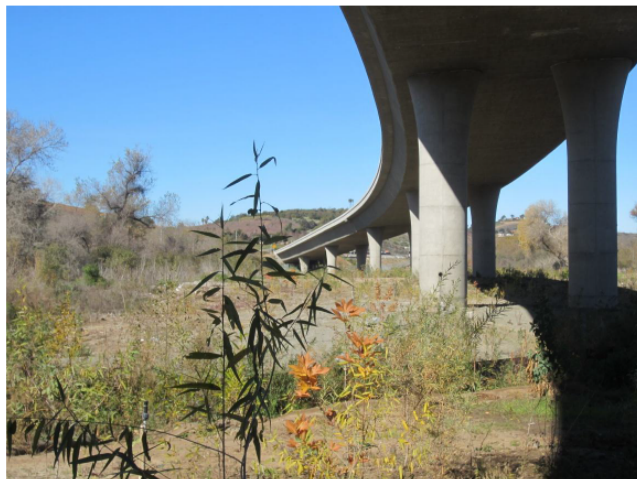
Figura 2.9: : Puente de San Luis Rey Río: Puente tipo cajón multicelular de concreto postensado Fuente: [1].
