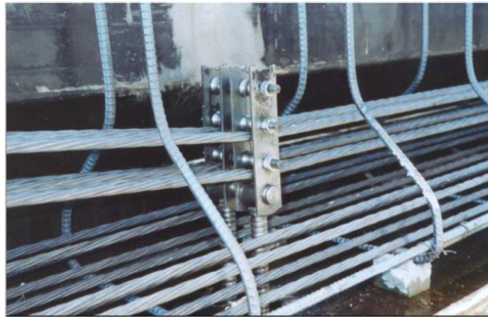
Figura 2.5: Sujeción de los torones en la cama de prefabricados Fuente: [1].
