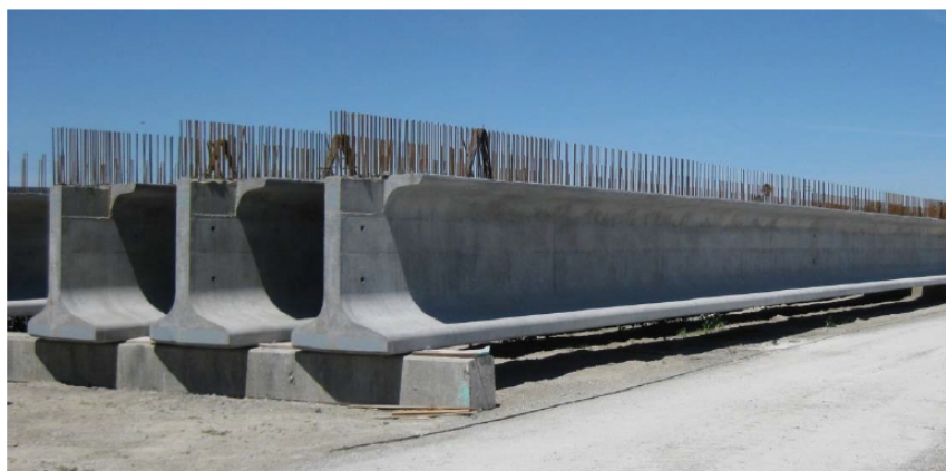
Figura 2.2: Vigas pretensadas tipo I Fuente: [1].
