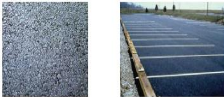
Figura 2. 3 Aplicación de mezcla bituminosa porosa
