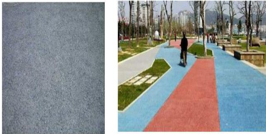
Figura 2. 4 Aplicación de concreto poroso
