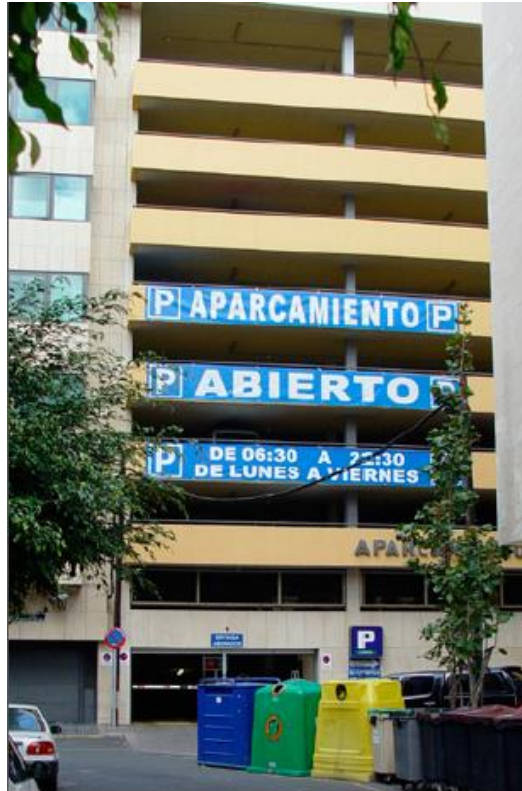
Figura 5: Edificio de estacionamiento. Fuente: Rye (2010).
