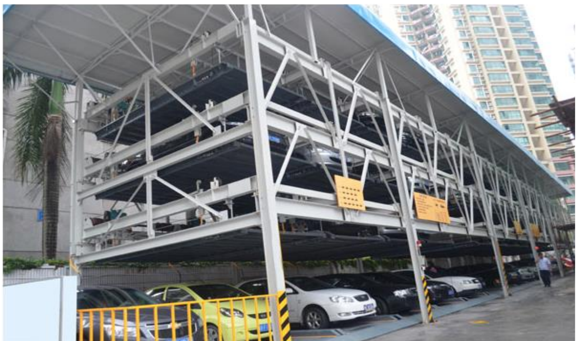
Figura 41: Sistema inteligente PSH de 4 niveles. Fuente: http://www.dsautoparking.com/ , citado por Calle C. (2014, p. 42)
