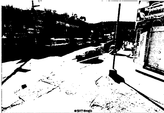
Figura 3.2: Vista de la Av. Ramón Castilla y Jr. José C. Mariátegui sin cruce peatonal.
