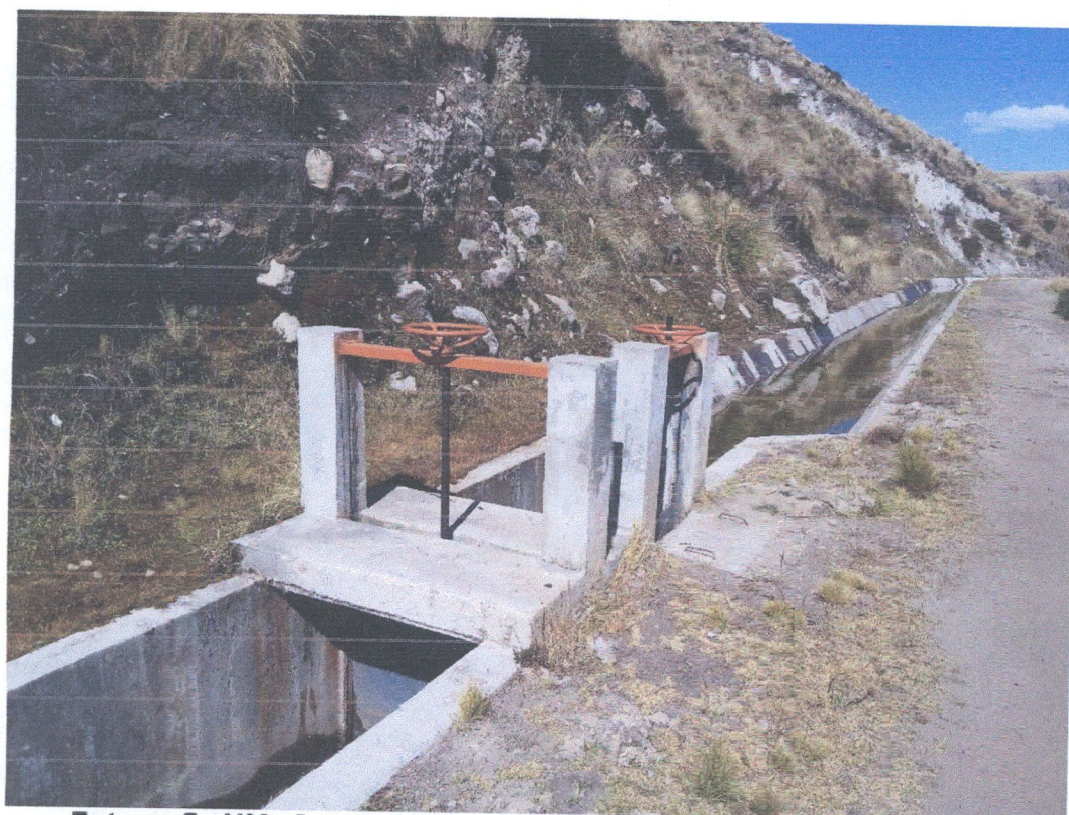
Fotografía N°2: Compuerta de regulación, donde se realizo el izaje correspondiente.
