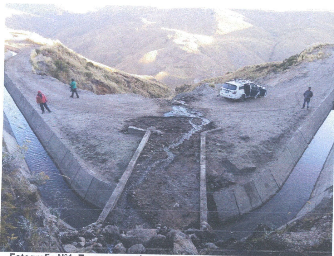
Fotografía N°1: Tramo curvo de canal de Suytucchocha escogido para el presente informe
