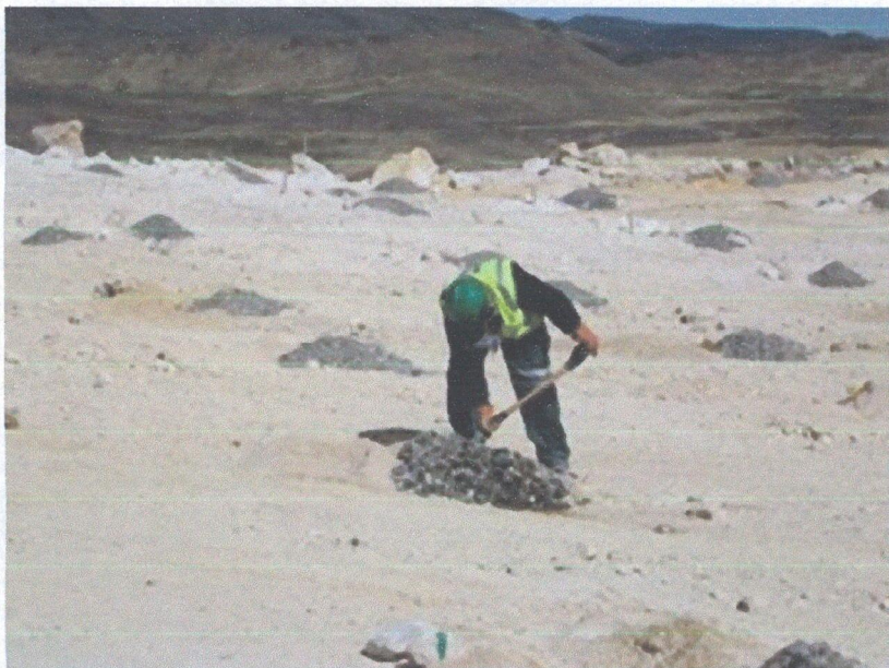
Figura 36: Llenado del taco de los taladros de voladura. Fuente: (foto tomado en Mina Breapampa.
