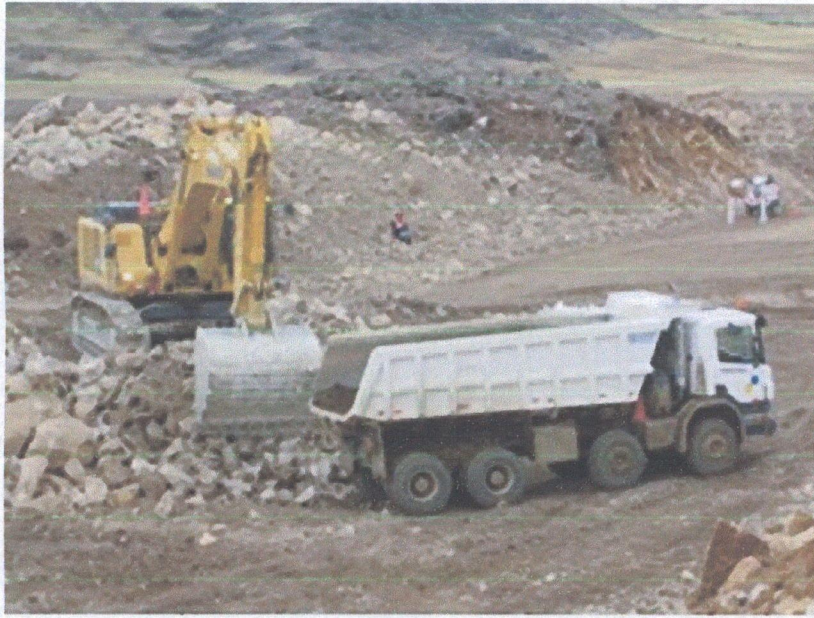
Figura 37: Carguío de mineral en el tajo. Fuente: (foto tomado en Mina Breapampa.
