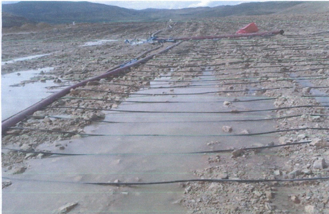
Figura 42: Empozamiento de celda de lixiviación. Fuente: (foto tomado en Mina Breapampa).
