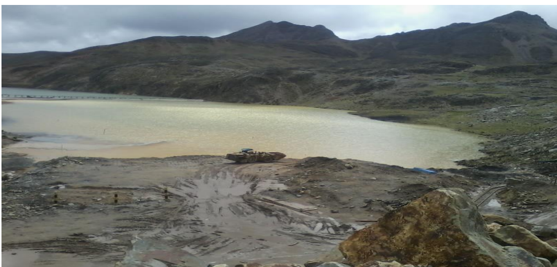
Fotografía 13: Limpieza de material acopiado
