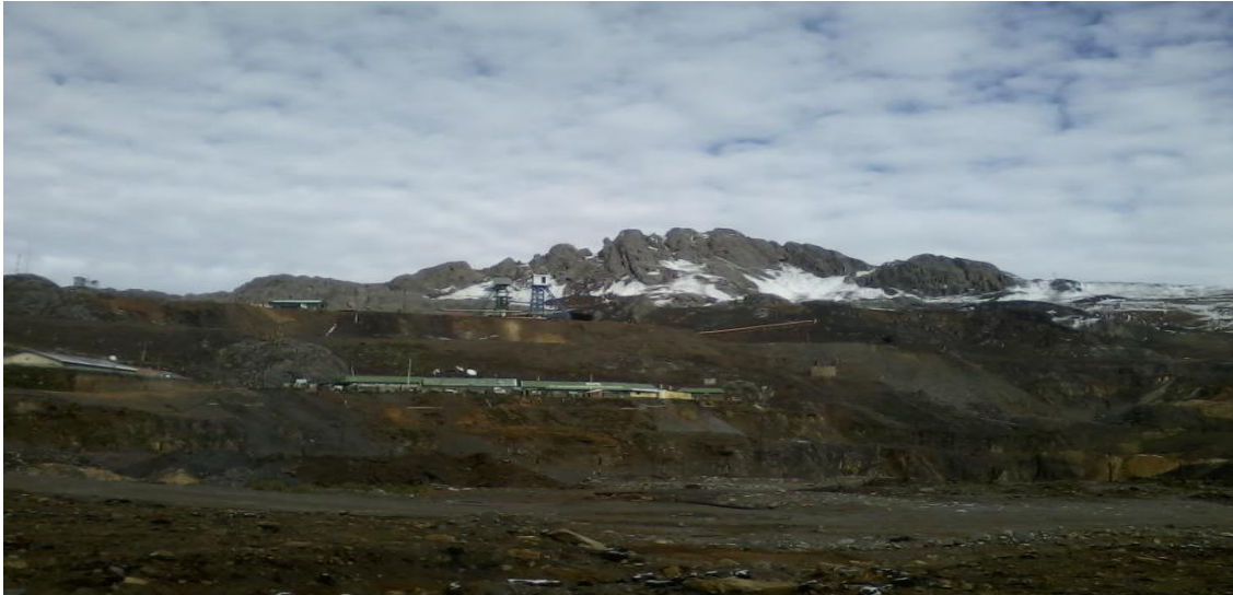
Fotografía 08: Vista panorámica del Pique Central y Pique Mascota
