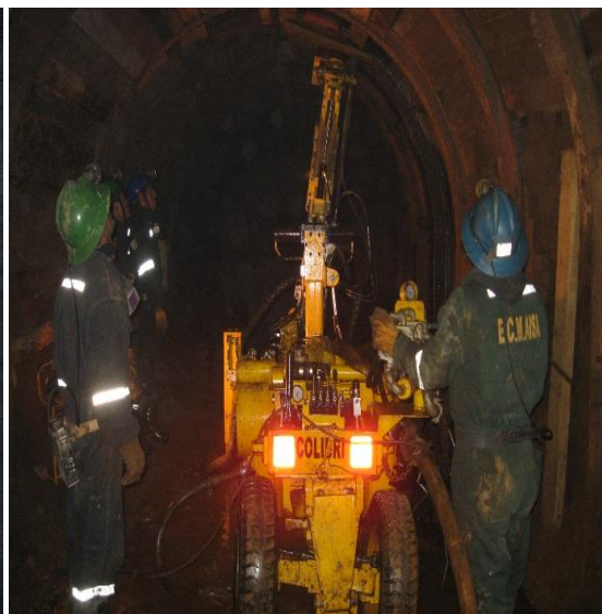
Fotografía 03: Colibrí realizando perforación
