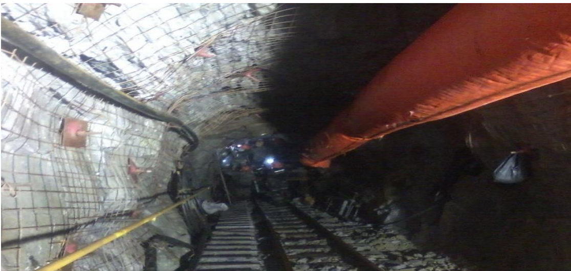
Fotografía 18: sostenimiento con malla electrosoldada y pernos helicoidales
