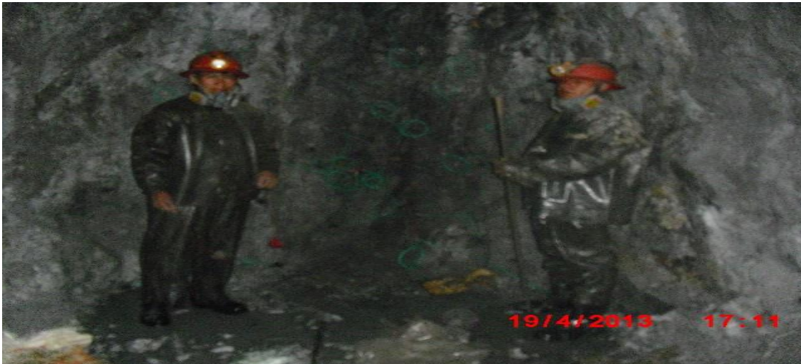
Fotografía 21: Carguío con dinamita y pentacord la malla de perforación
