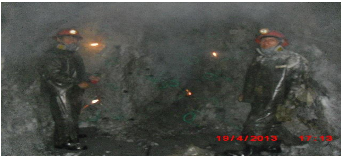
Fotografía 22: Chispeo de la malla de perforación
