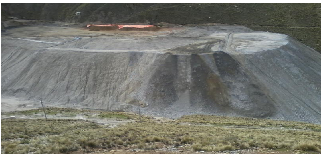
Fotografía 12: Acopio de mineral y desmonte
