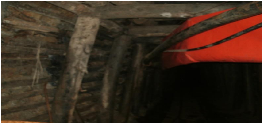
Fotografía 19: Sostenimiento con Cuadros
