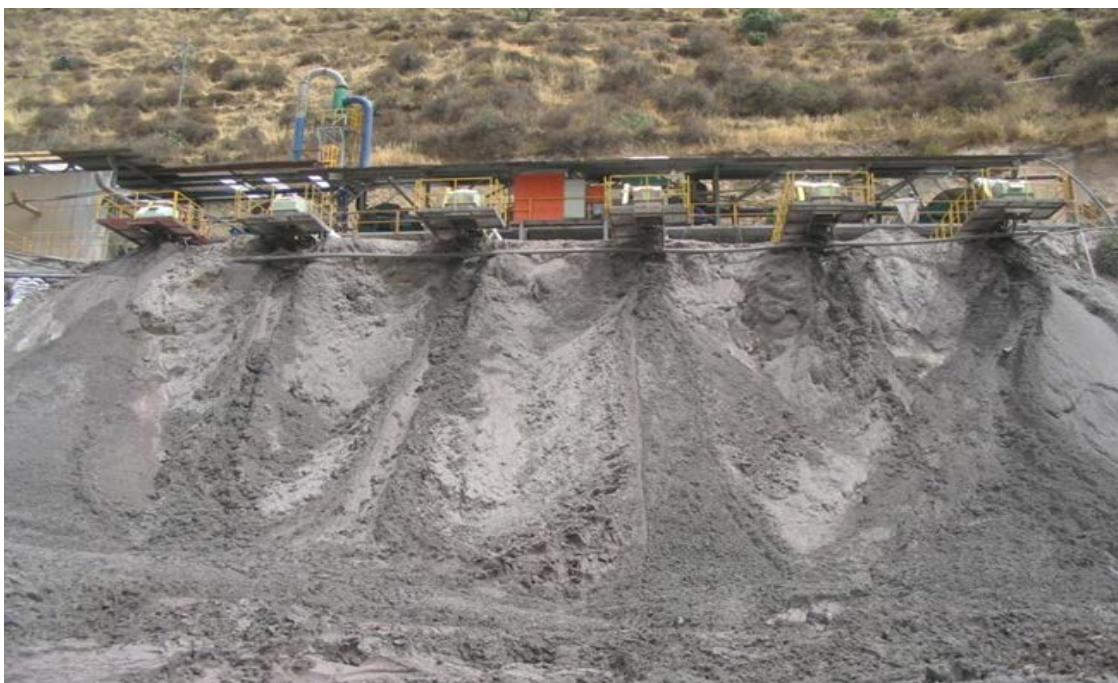
FOTO N° 18 ELIMINACION DE RELAVES DESPUES DE FILTRADO
