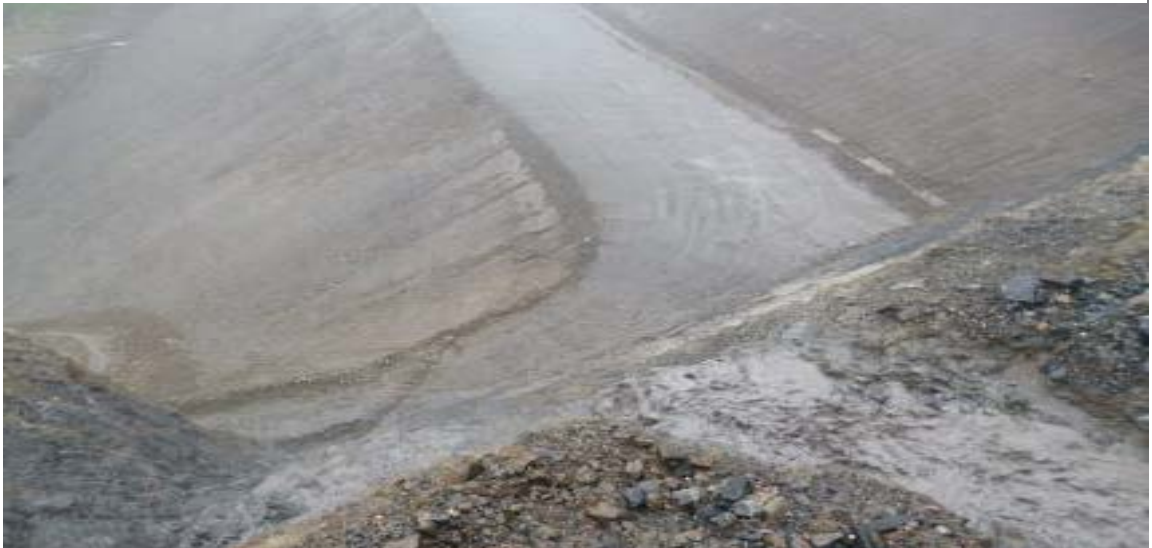
FOTO N° 11 ACCION DE LAS LLUVIAS EN CANCHAS DE RELAVE
