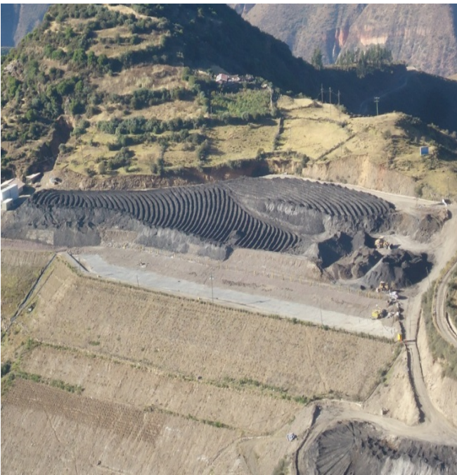
Foto N° 25: Proceso de secado y oreo de relaves en forma mecánica – Catalina Huanca
