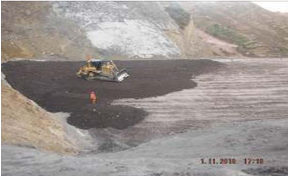
Foto N° 27: Proceso de tendido y conformado de mezclas
