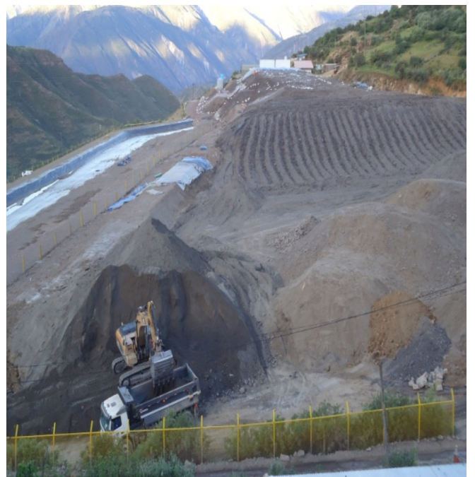
Foto N° 26: Proceso de mezclado de relaves con material de préstamo (OCH 8 – 10%)
