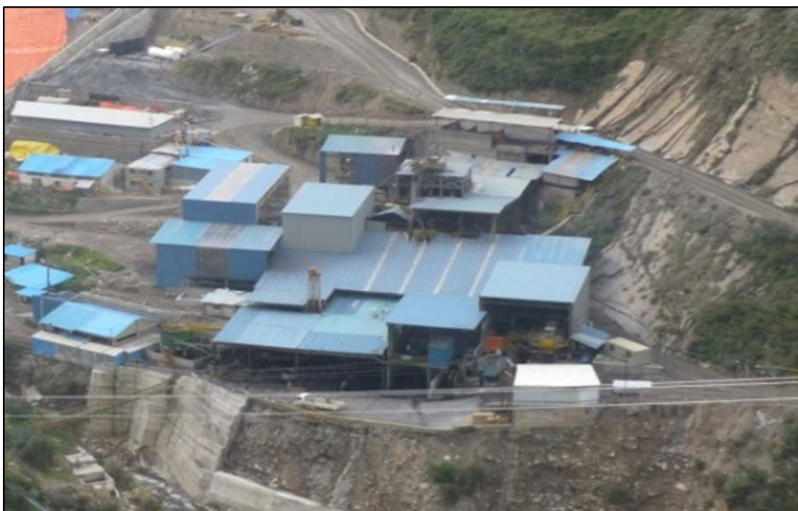
FOTO N°10 PLANTA CONCENTRADORA – GENERACION DE EFLUENTES DE MINA
