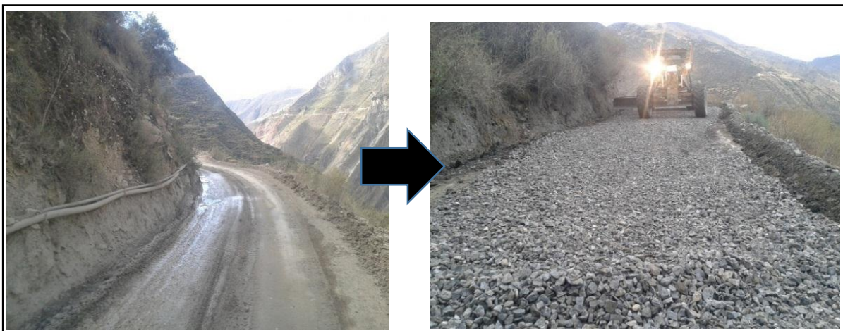
FIG.21 - "MANTENIMIENTO DE VÍAS SUPERFICIE"
