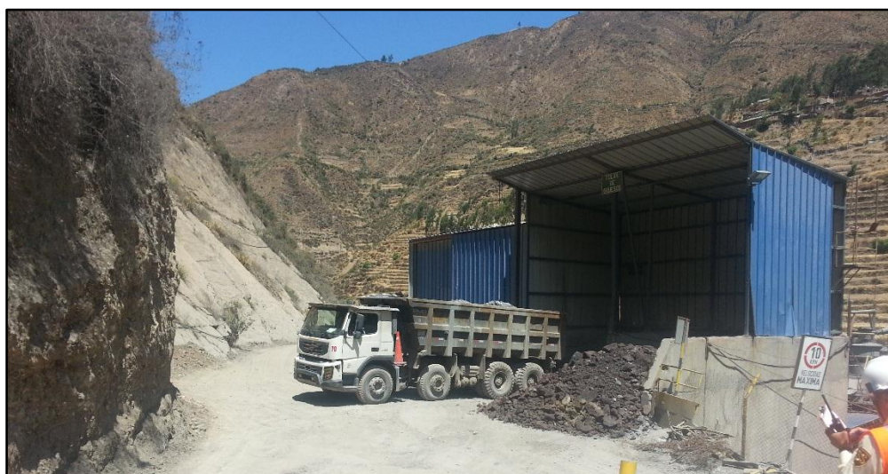
FIG. 15 - "volquete Volvo FMX 8x4, en operación de descarga de mineral"
