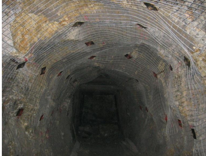
Figura N° 09: Sostenimiento con malla electro soldada.
