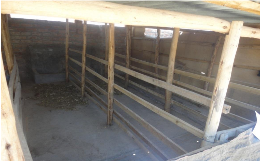
Imagen 03: Finalización de la construcción de los galpones del T1
