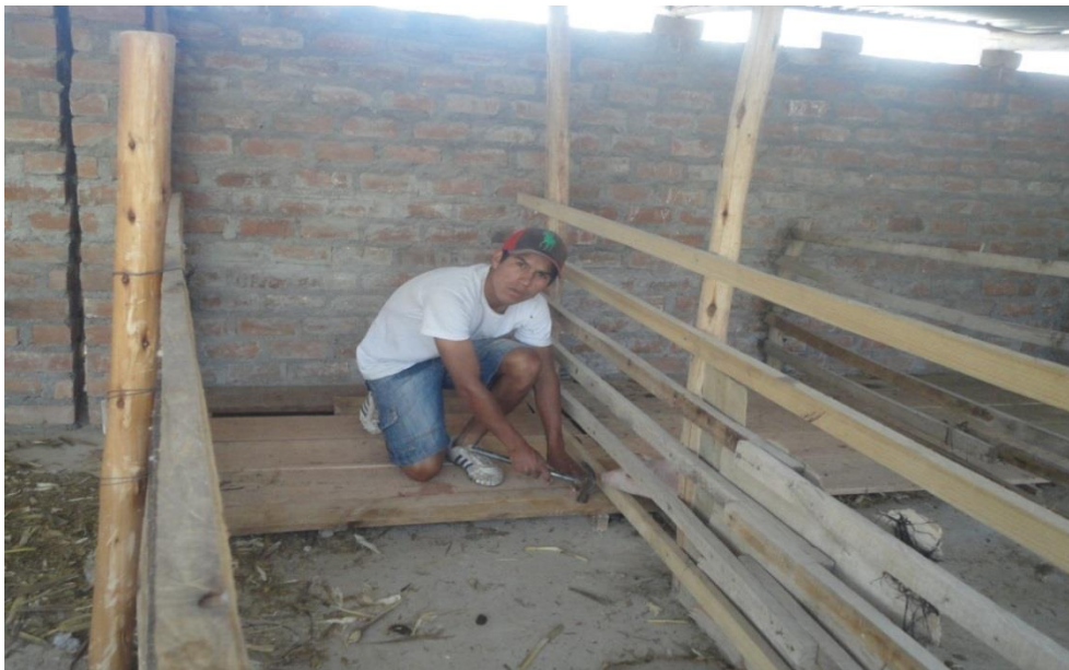
Imagen 02: Clavado de las maderas un 30% de piso (madera)
