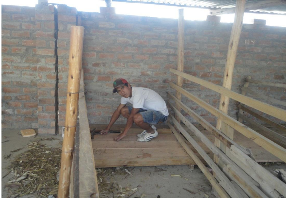
Imagen 02: Clavado de las maderas un 30% de piso (madera)
