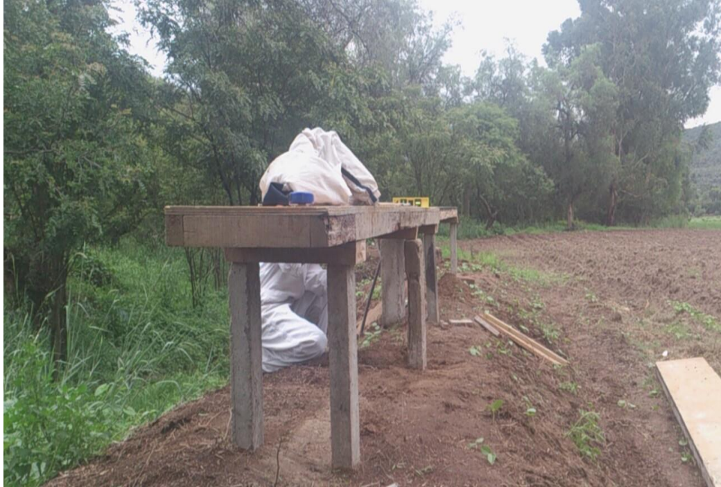
Foto N° 01 Instalación de banquetas para la colocación de los portanúcleos.
