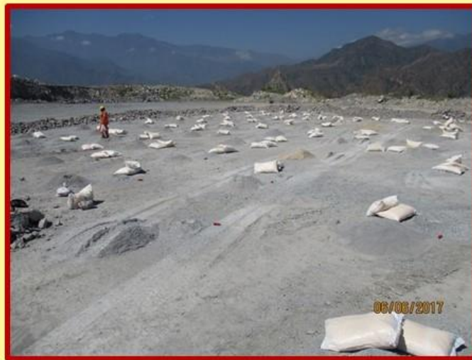
IMAGEN N° 3.4: Carguío de taladros para la voladura
