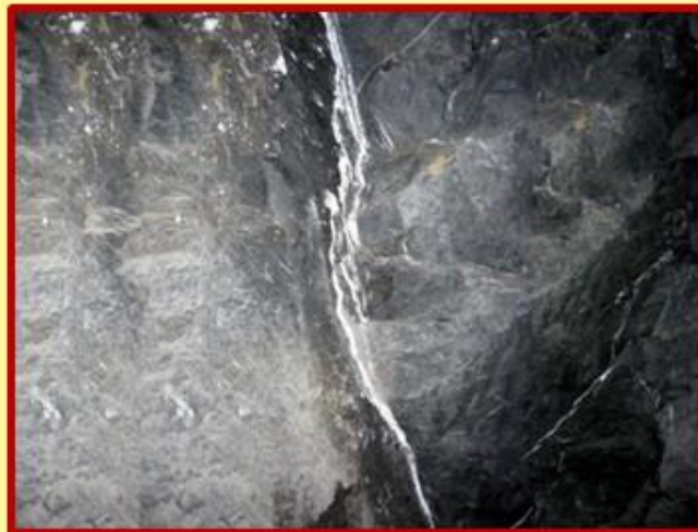
IMAGEN 4.19 Relleno de discontinuidades.
