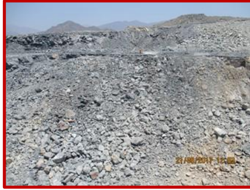
DESPUES: Voladura Primaria
