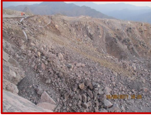
DESPUES: Voladura Primaria
