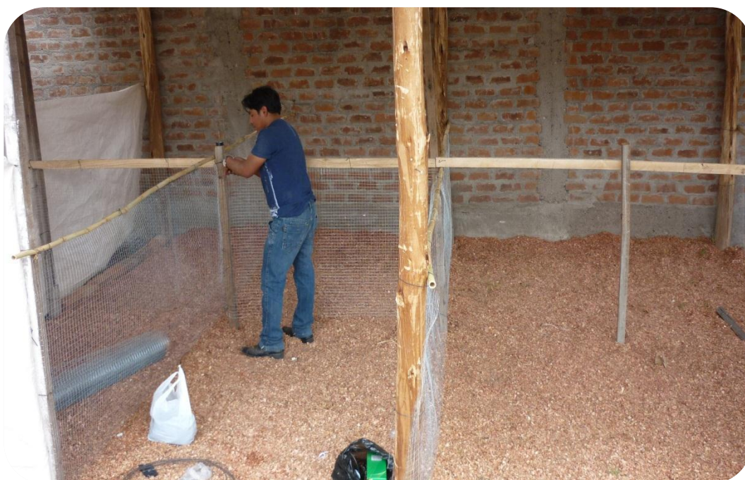
Foto 01. Construcción de galpones
