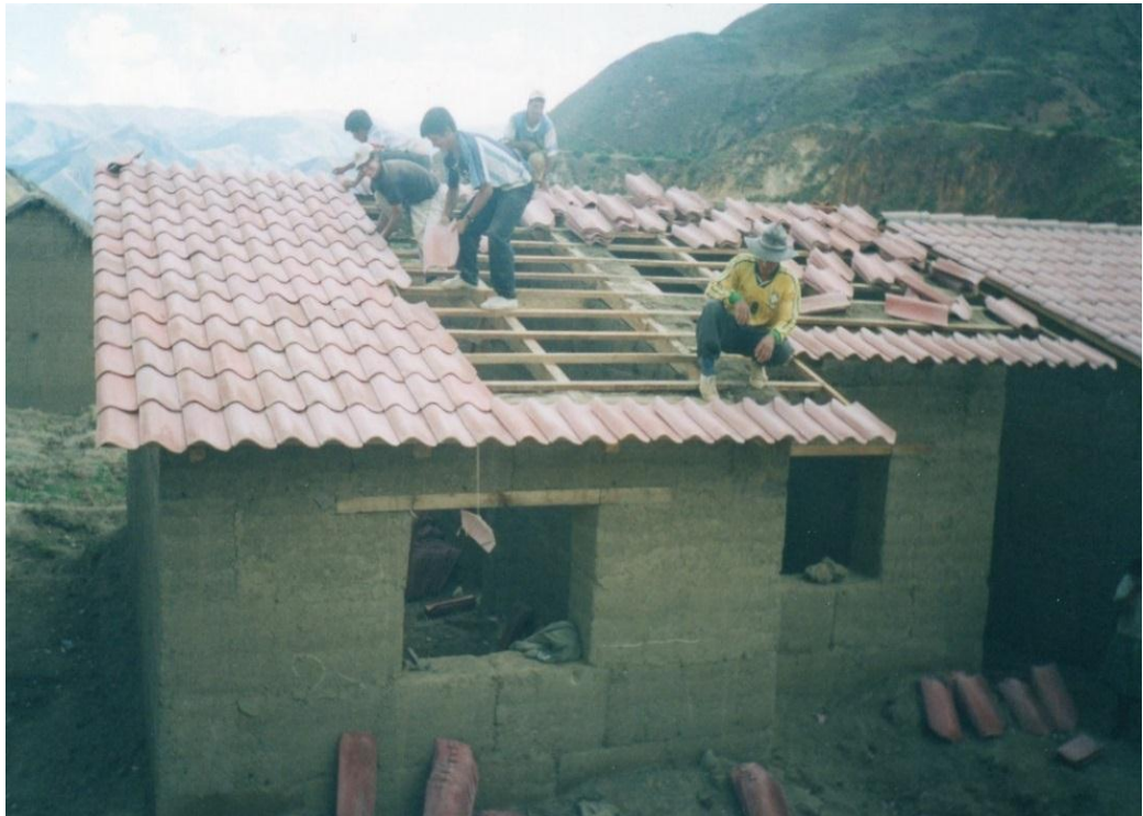
Fotografía 5. Vivienda rural cobertura con tejacreto – Modelo 3
