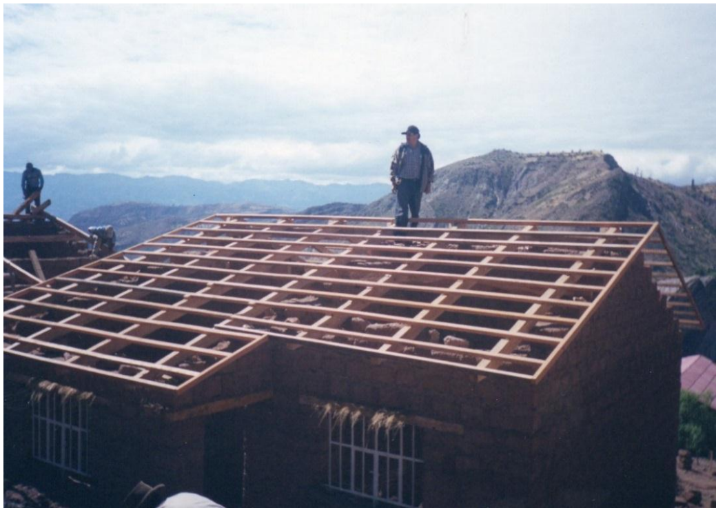
Fotografía 4. Vivienda rural proceso constructivo - Modelo 3
