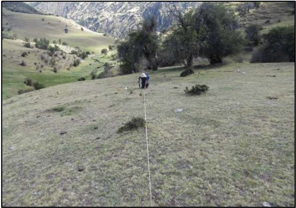
Imagen 09 Demarcación de la ubicación de reservorios en el centro piloto del anexo Tambo A
