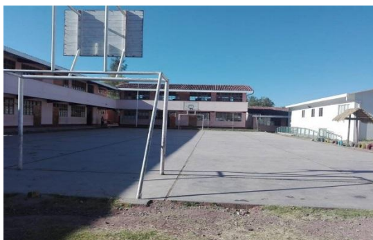
Figura 1. Patio de la I.E. primaria 38031 Mariscal Guillermo Miller Acos Vinchos
