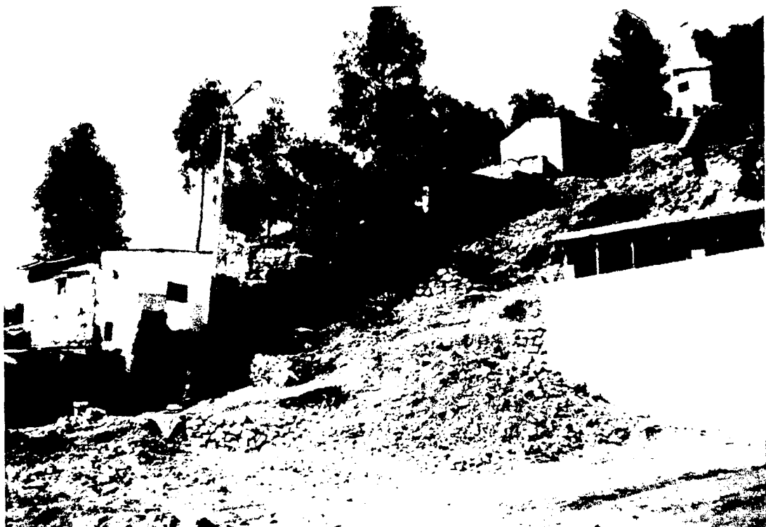
Foto N° 17. Secuencia de casas en una ladera empinada y de material suelto.
