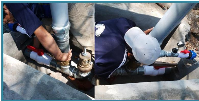
Figura III.41. Montaje de la bomba de ariete con la tubería de impulsión.
