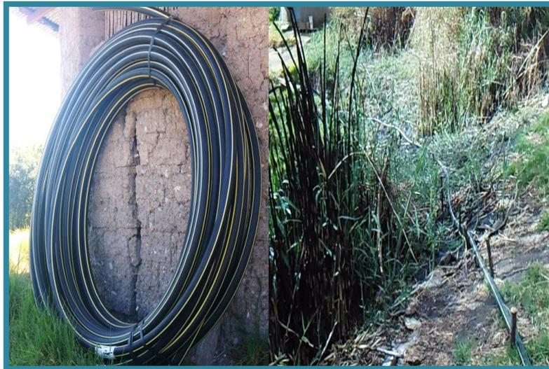
Figura III.44. Tendido de manguera HDPE de 1 ½” (50mm).
