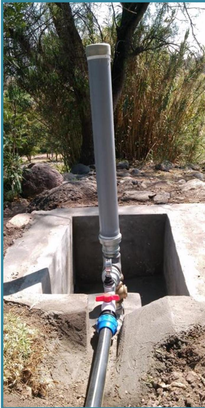
Figura III.46. Bomba de ariete interconectada a la tubería de impulsión y descarga.
