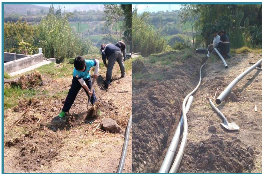
Figura III.34. Instalación de la línea de conducción (captación-cámara de carga)
