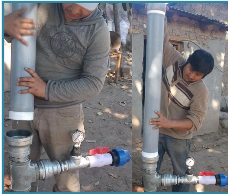
Figura III.30. Disposición final de la cámara de aire
