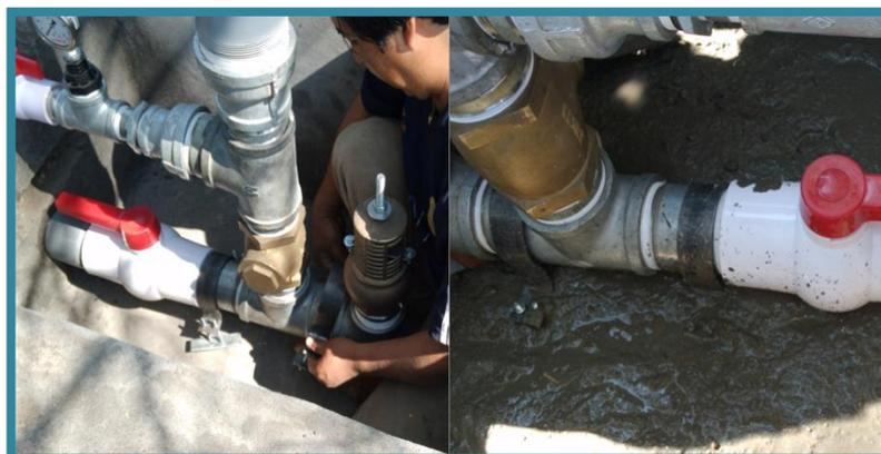
Figura III.42. Fijación con abrazaderas de platina a la base de concreto.
