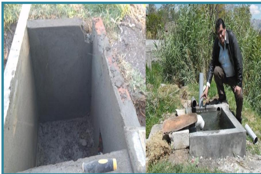
Figura III.36. Revestimiento y obra final de la cámara de carga.
