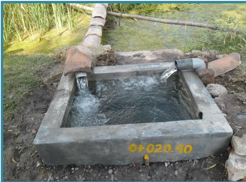
Figura III.48. Llenado con agua de la cámara carga.
