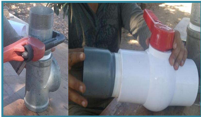
Figura III.22 Montaje de niples y unión roscada a los accesorios.
