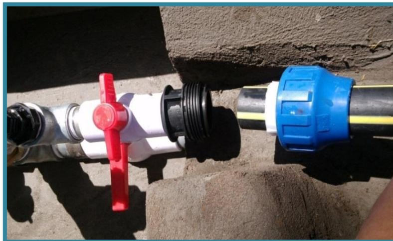
Figura III.45. Conexión entre la manguera HDPE y la bomba de ariete.
