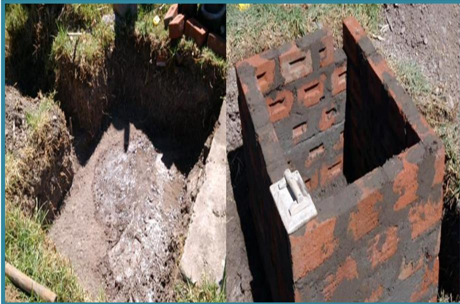
Figura III.35. Excavación y albañilería en la cámara de carga.
