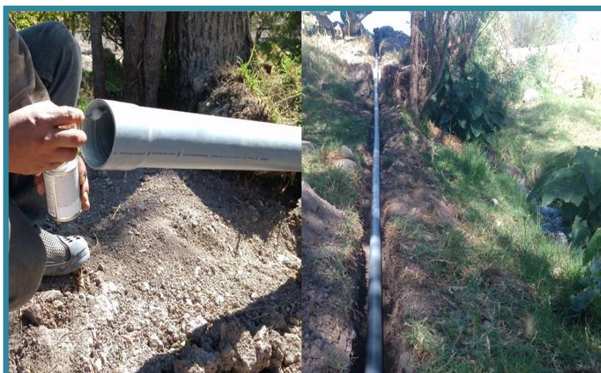
Figura III.38. Instalación de tubería de impulsión.
