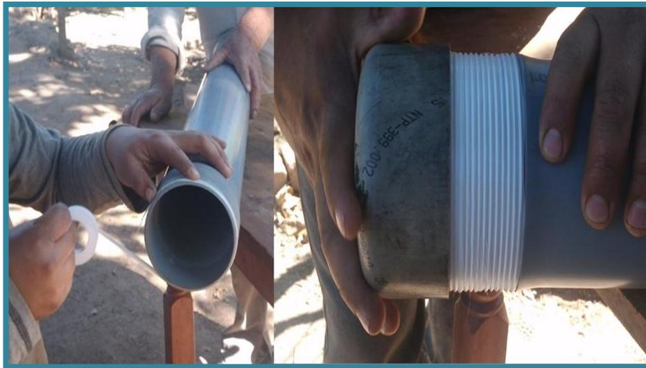
Figura III.29. Tefloneado y montaje de tapón de 4" con niple de PVC de 4"x1.10m
