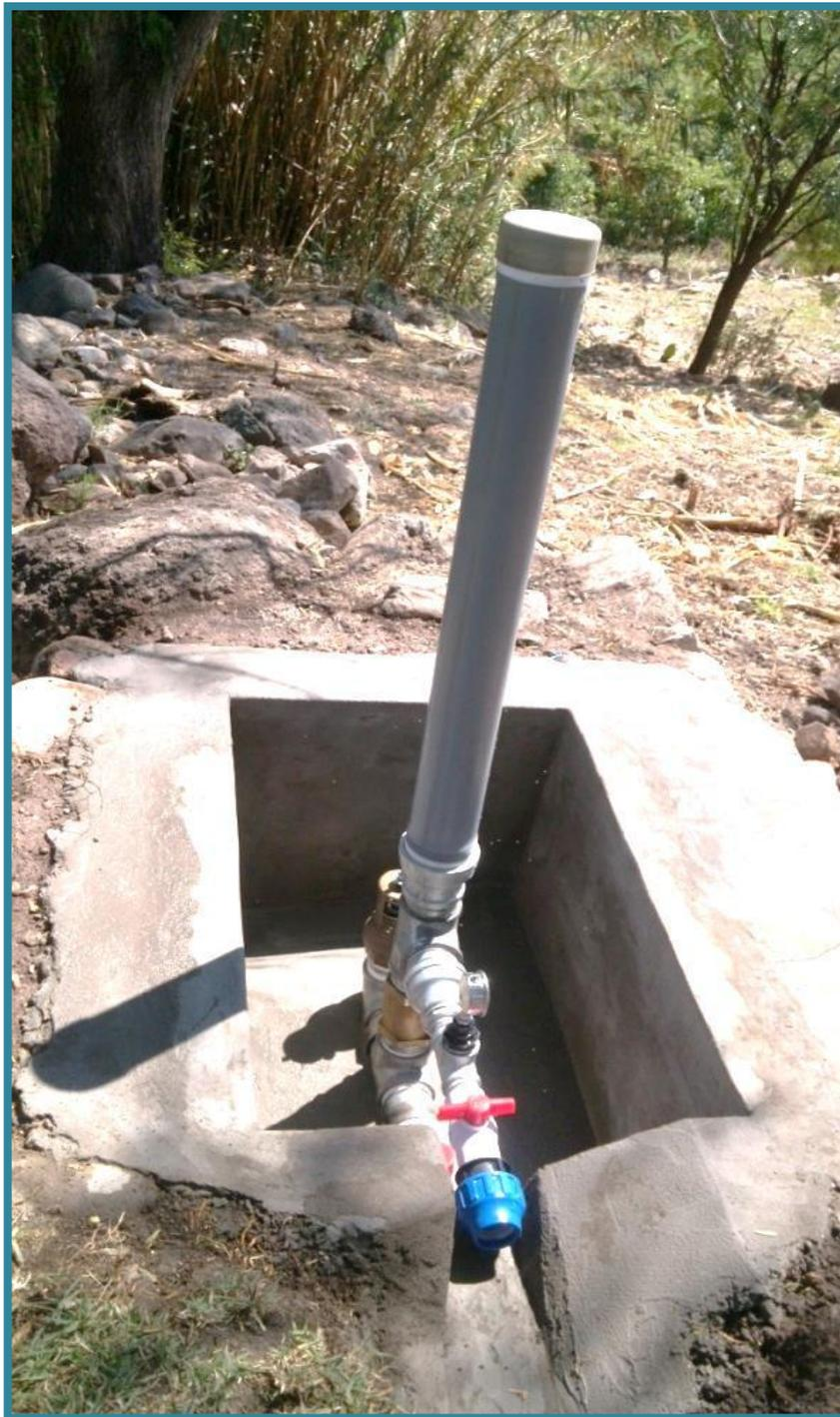
Figura III.43. Bomba de ariete hidráulico instalada.
