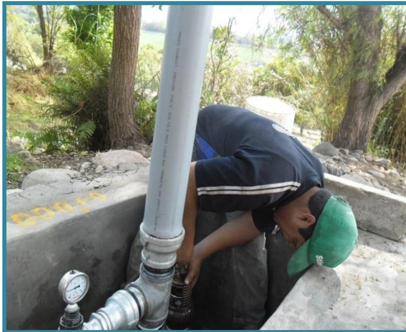
Figura III.47. Regulación de la carrera del vástago de la válvula de impulsión.
