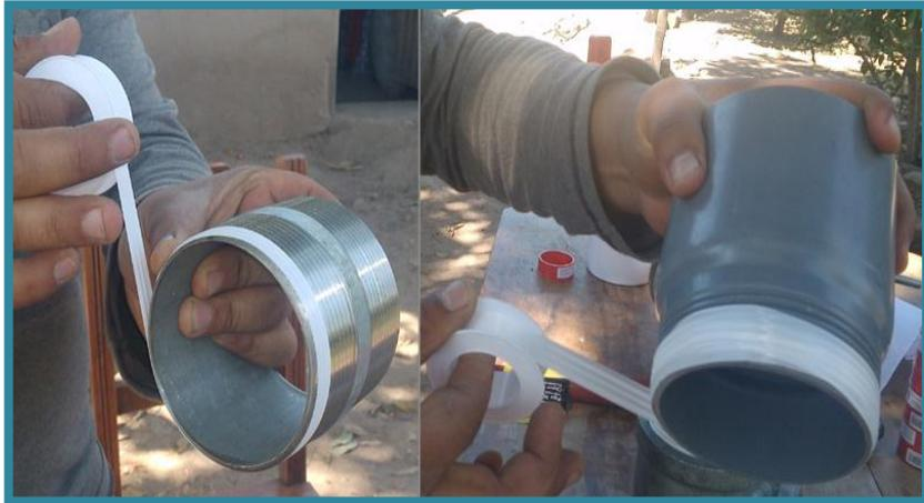
Figura III.21. Colocación de teflón en los niples y unión roscada.
