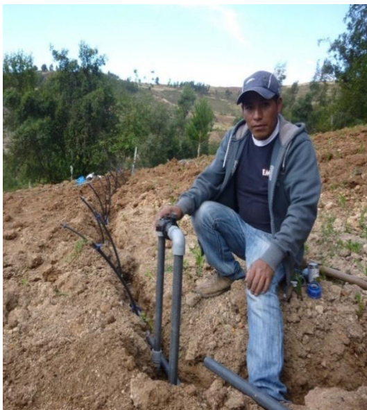
3. Instalación del arco de riego y los bigotes.
