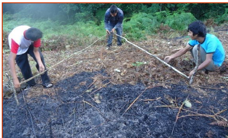
Figura 2.3. Marcación de terreno para realizar la instalación.
