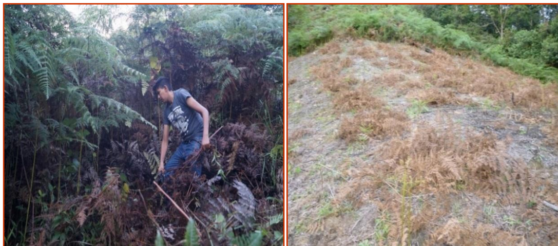
Fotografía A1. Limpieza de área para instalación de Eucalyptus urograndis .
