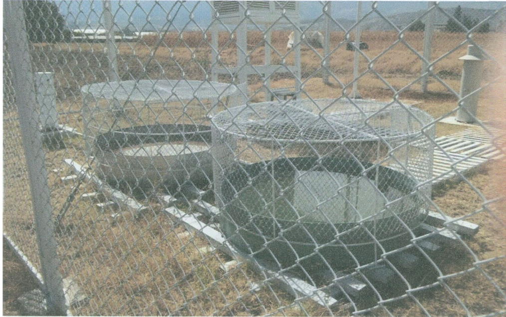
Foto N° 03: Vista del tanque evaporímetro, el tanque se encuentra protegida por una malla olímpica, este equipo es el encargado de medir la evaporación.
