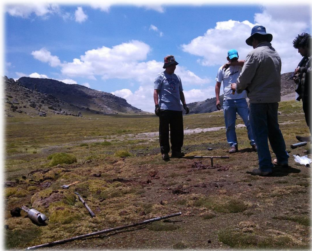
Foto N° 04 perforacion para instalar piezometros.
