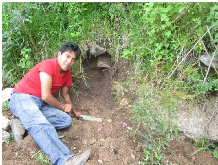
Figura 8. Corte de tubería para la muestra de obstrucción. Fuente: elaboración propia (2014)
