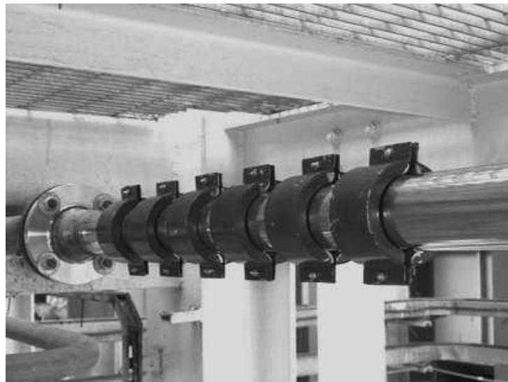
Figura 5. Montaje del dispositivo magnético en tuberías de INOX Fuente: Gálvez (2010)
