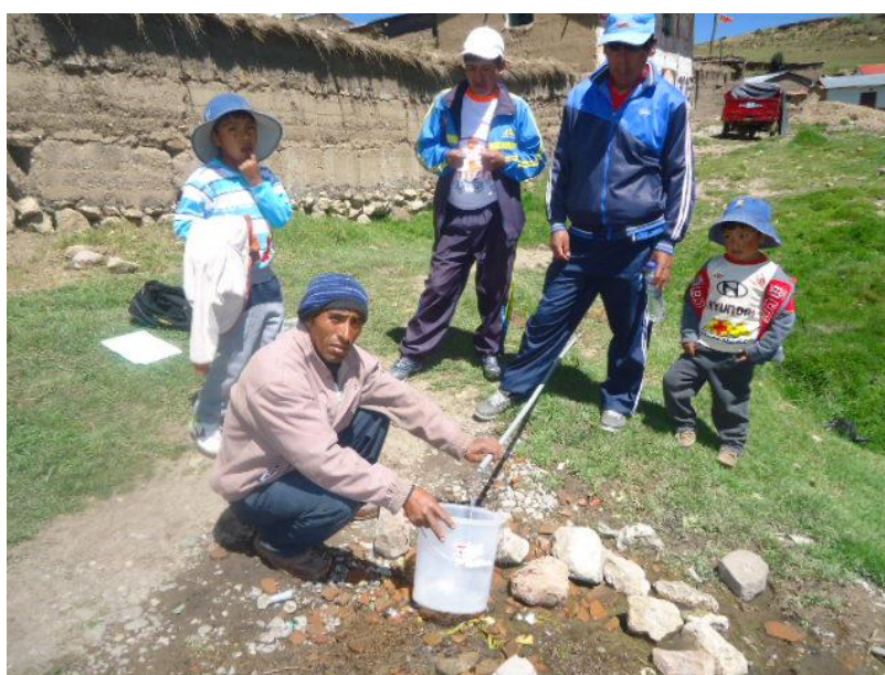
Figura 3. 36: Tubería rota de la cual se abastecen varias familias
