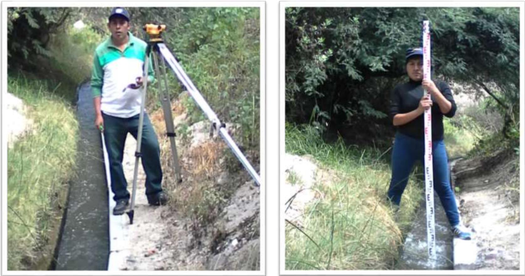
Figura 3.4: Nivelacion topográfico del canal abierto
