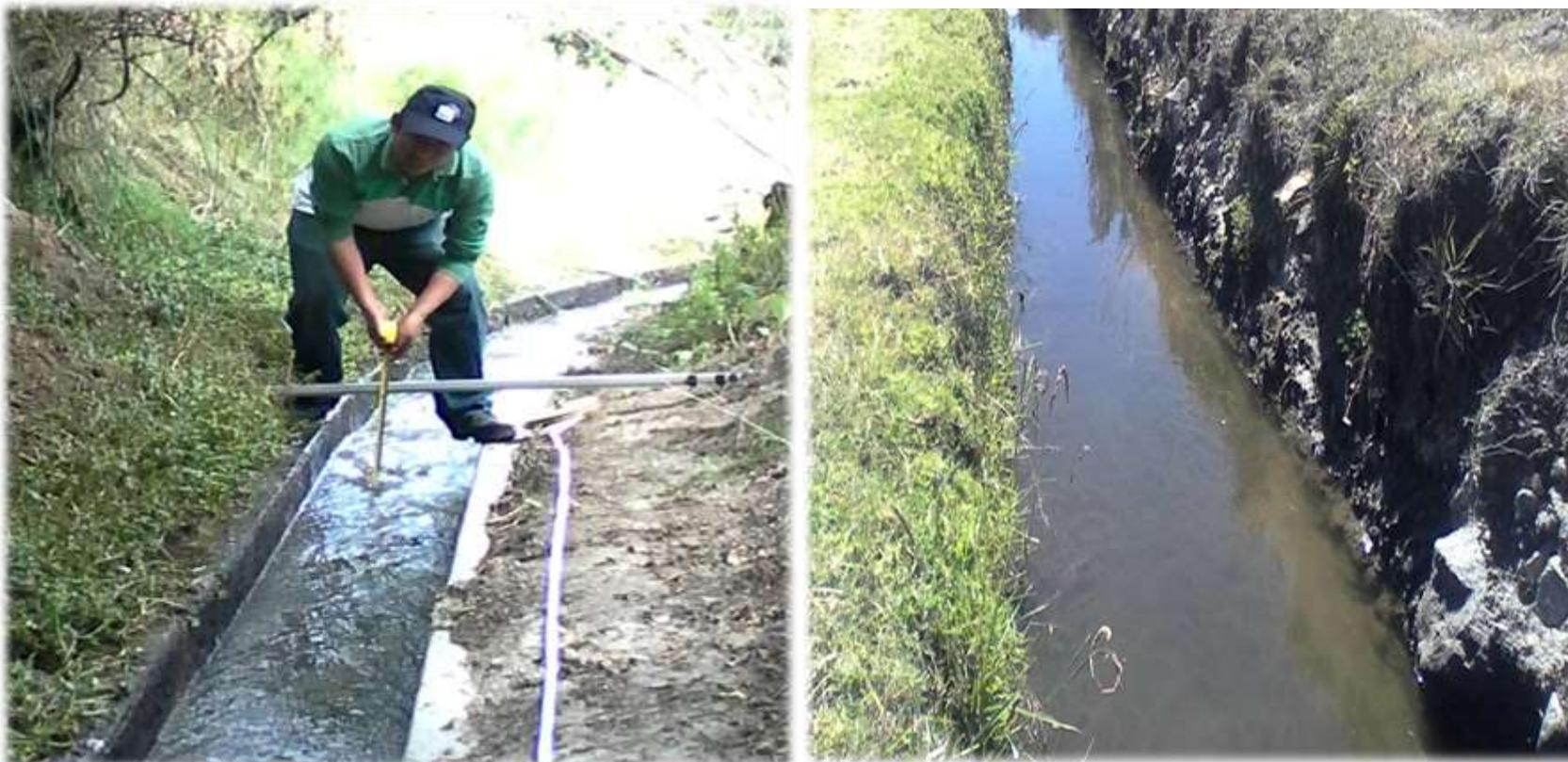
Figura 3.3: Medicion de la seccion del canal abierto
