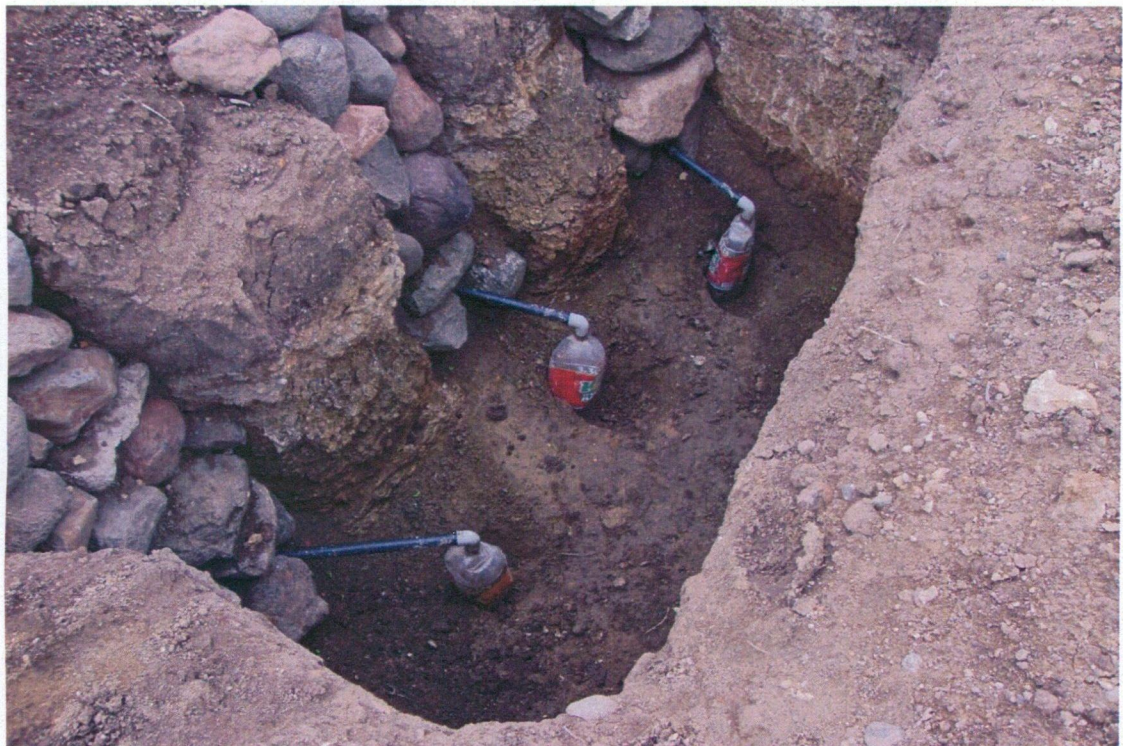
TRINCHERA DE REGISTRO Y LOS COLECTORES DEL AGUA DRENADO
