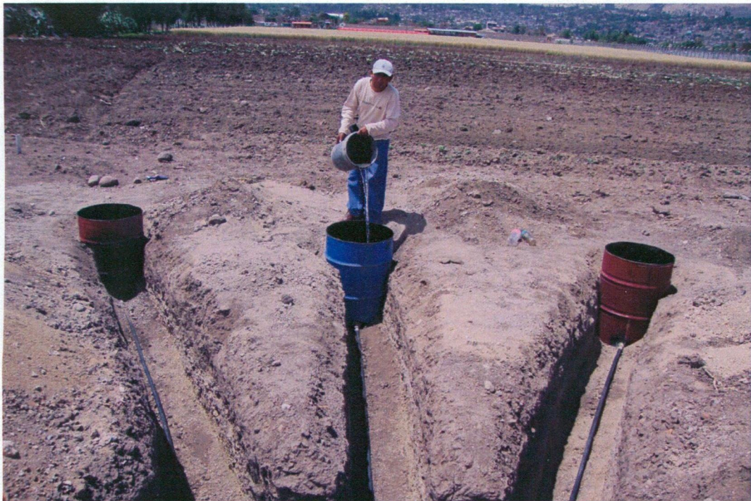
PRUEBA HIDRÁULICA DE LOS LISÍMETROS INSTALADOS
