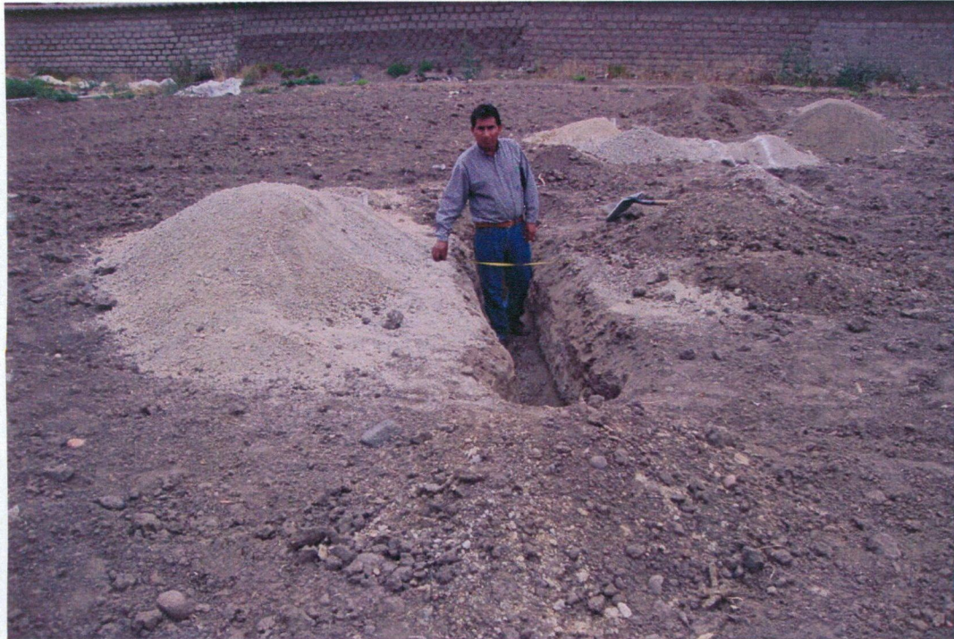
EXCAVACIÓN PARA LA INSTACIÓN DE LOS LISÍMETROS
