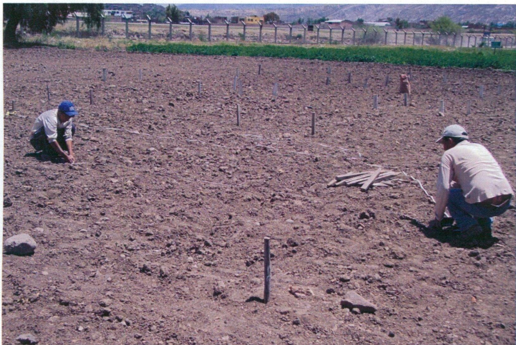
TRAZO Y REPLANTEO DEL TERRENO PARA LA INSTALACIÓN DE LOS LISÍMETROS
