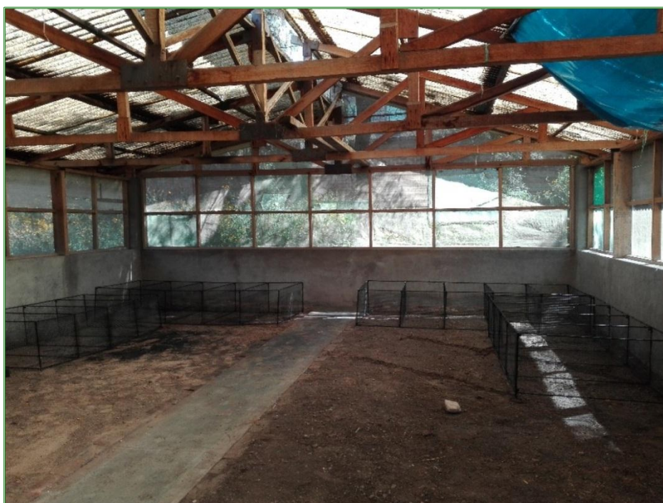
Foto 01 En la imagen se observa el área de instalación para la evaluación
