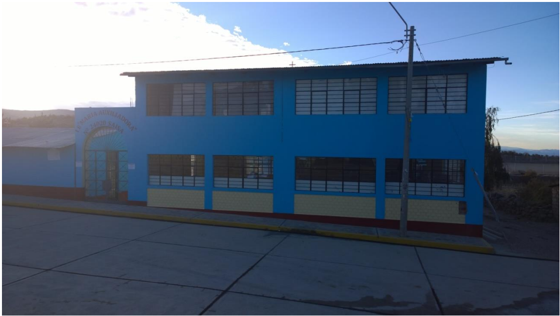
Foto N° 13 Vista panorámica el colegio de la municipalidad de SAISA
