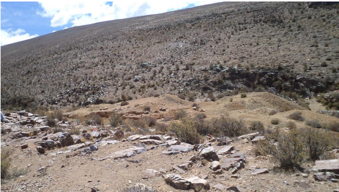
Foto N° 08 Proyecto construcción Pique exploración y extracción Marquiga
