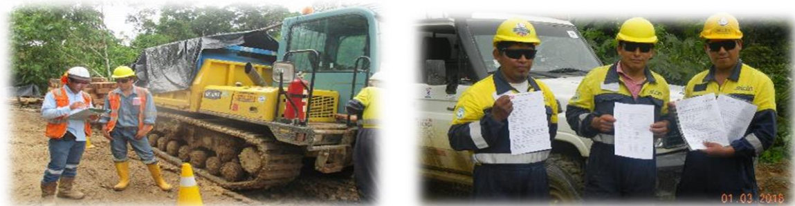
Figura 3.14. Monitoreo en el Derecho de Vía DDV
