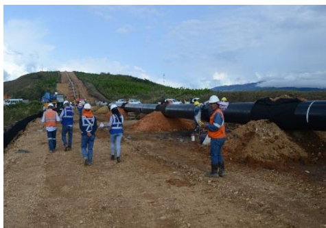
29 de Junio, Quello Uno Revestimiento KP 150+250.
