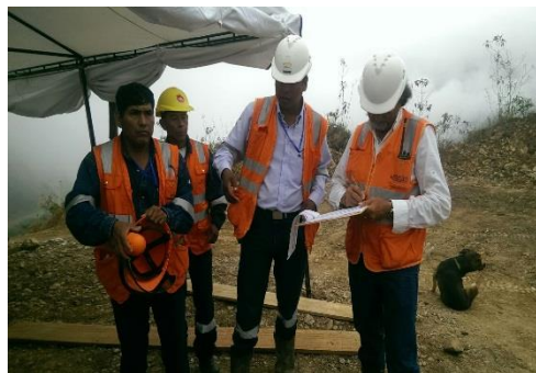
29 de Junio, Quello Uno Soldadura Manual KP 153+000.
