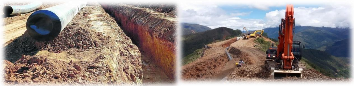
Figura 3.7 Apertura Excavación de Zanjado
