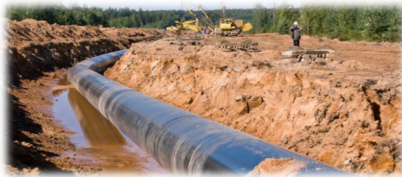
Figura 3.8. Bajado de Tubería en DDV Fuente: sicim
