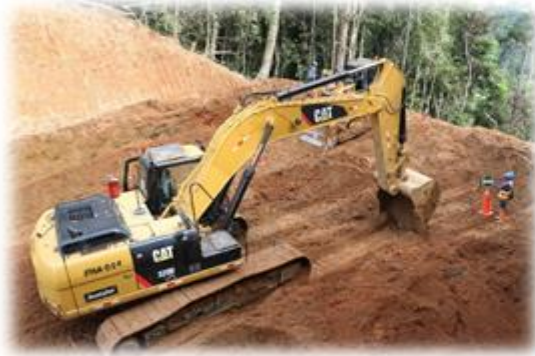
Figura 3.3. Apertura de Derecho de Vía DDV
