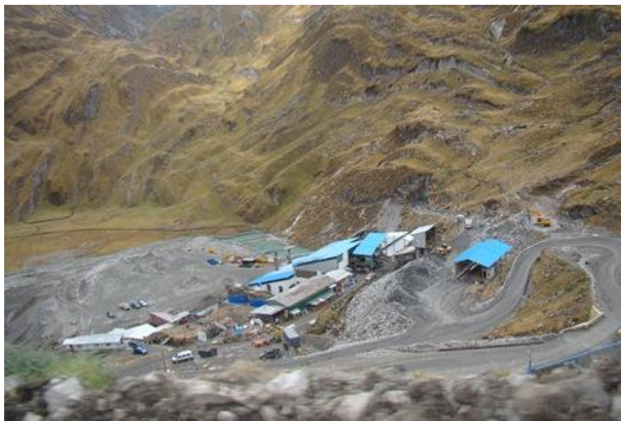
Foto N° 2 planta concentradora en el nivel 0
