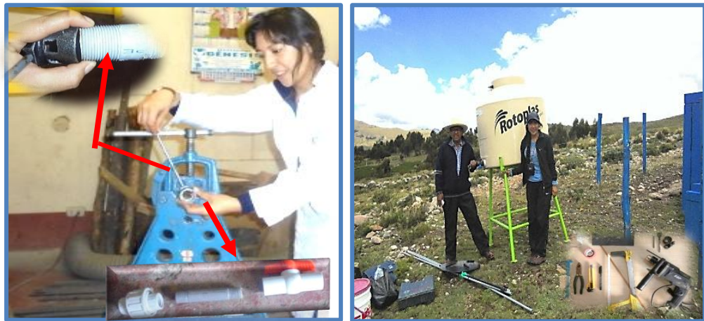
Figura 3.19 Diseño de nipples en el taller de la UNSCH y el montaje del sistema de cloración por goteo en la comunidad de Capillapata.
