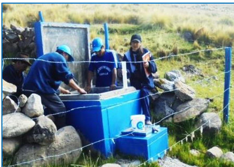
Figura 3.6 Captación de agua de manantial de la comunidad de Capillapata - 2016.
