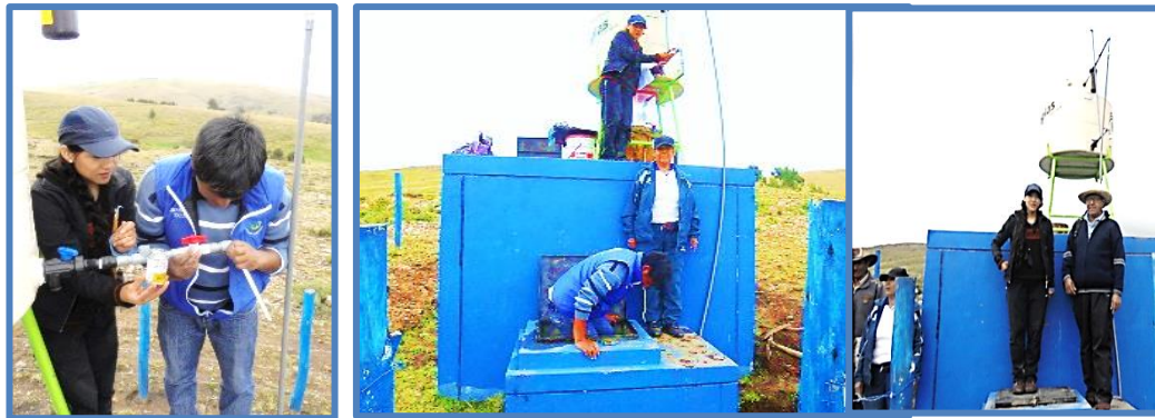
Fotografía 02. Instalación del sistema de cloración por goteo.
