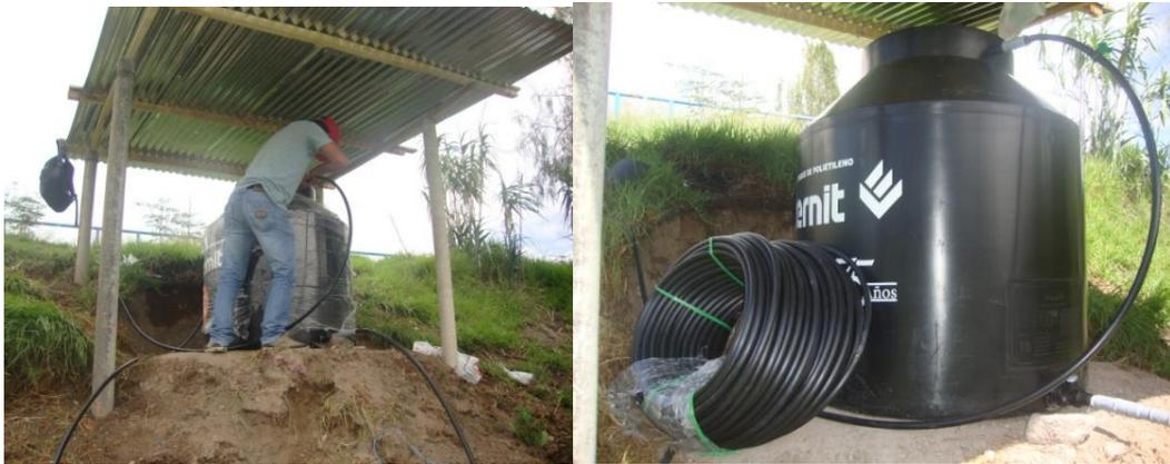
Figura 3.11: Instalación de tanque de almacenamiento
