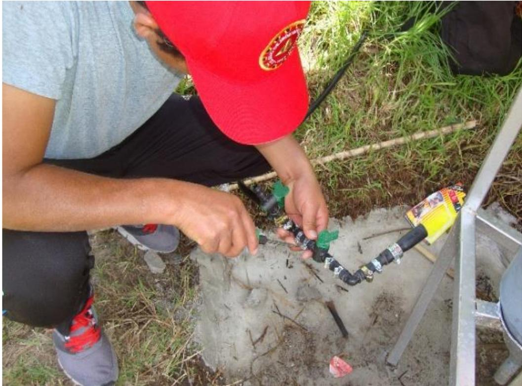
Figura 3.14: Instalación de válvulas de muestreo del afluente del reactor UASB
