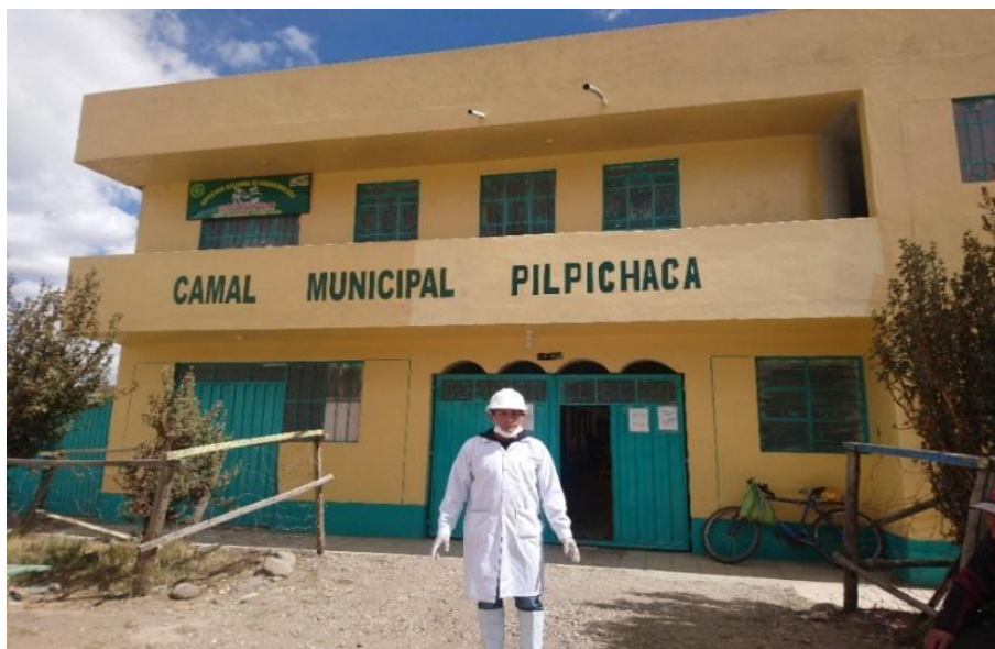
Figura 2.1. Vista panorámica externa del Matadero Municipal de Pilpichaca
