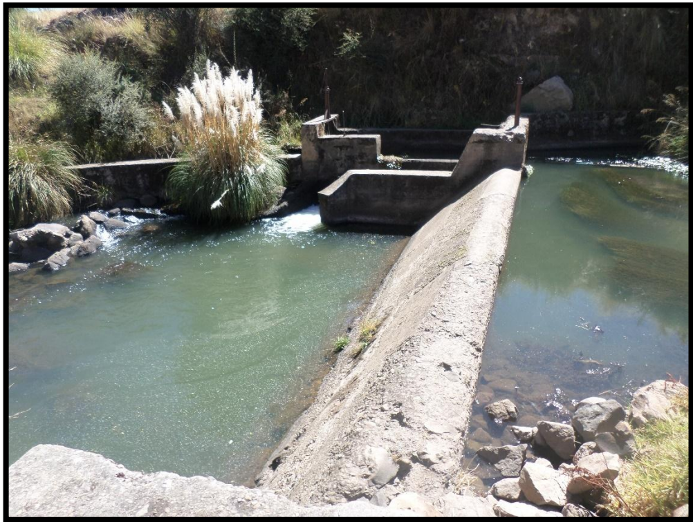
Fotografía 6: Captación antigua para la Piscigranja de la UNSCH
