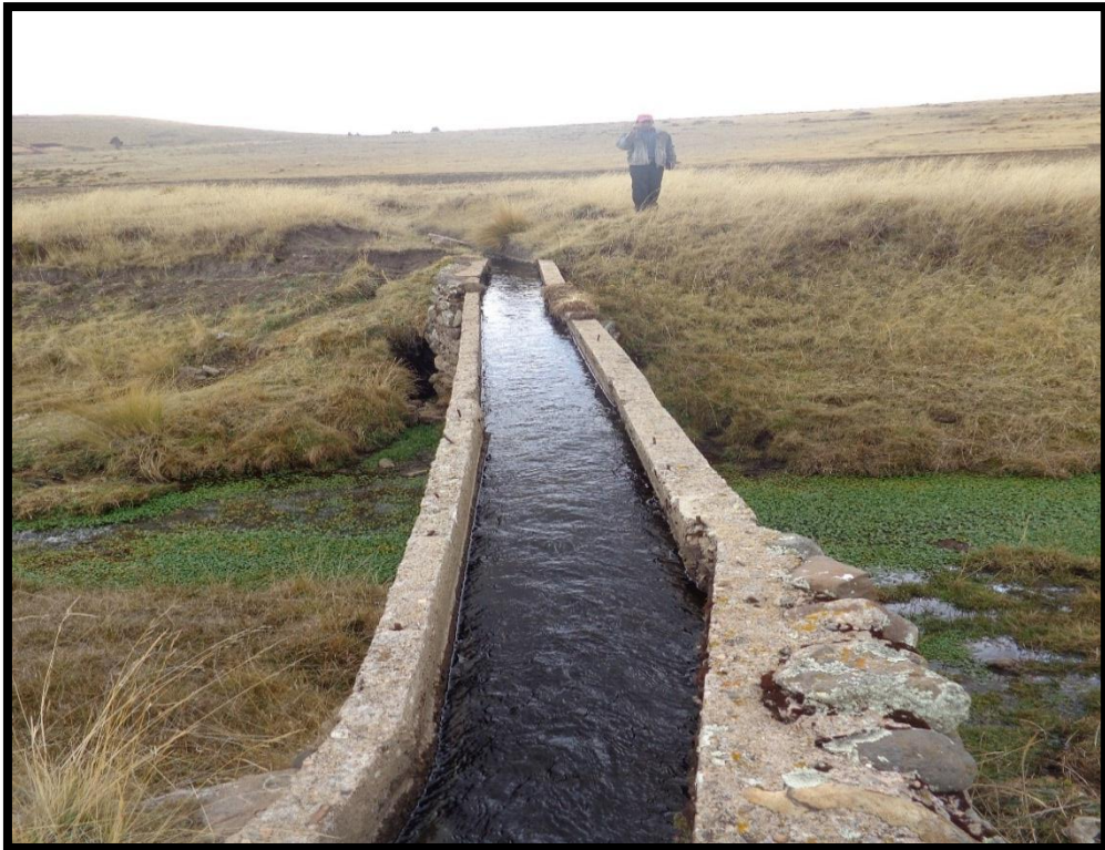
Fotografía 23: canal de riego margen derecho -satica
