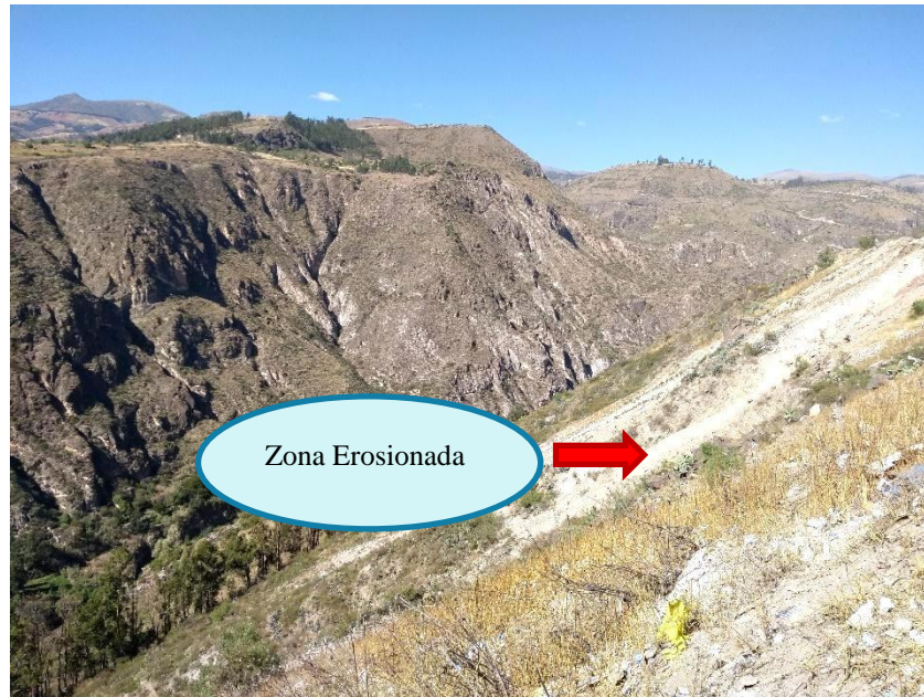
Figura 3.13: Fotografía San Martín de Pucara, zona erosionada y de alta pendiente II
