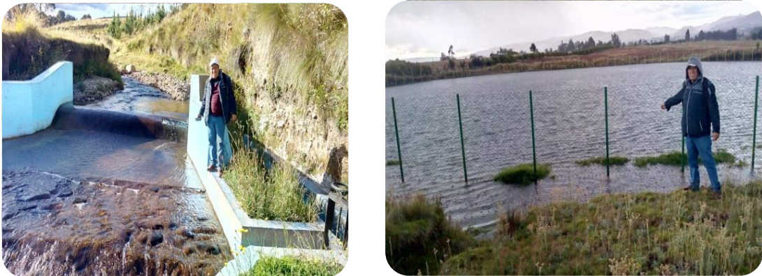
Figura 2.4: Evaluación de la bocatoma y el reservorio
