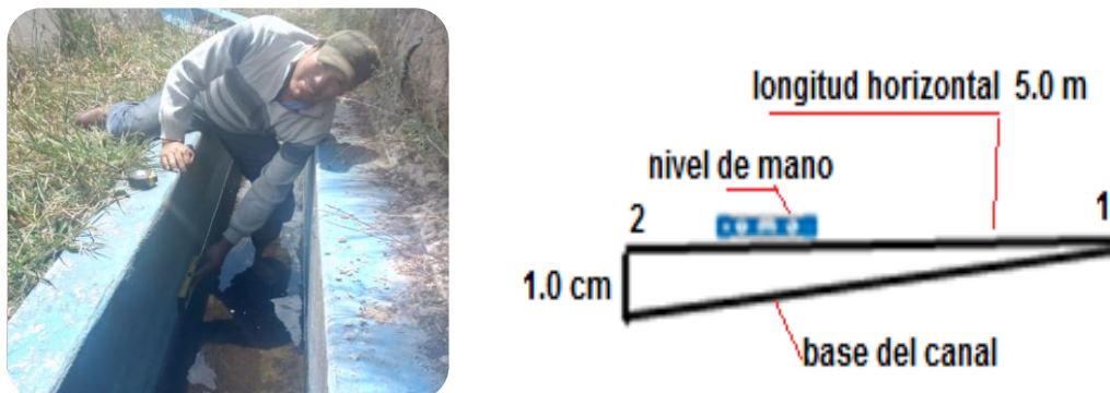
Figura 2.7: Determinación del desnivel en canal de ingreso a la tubería
