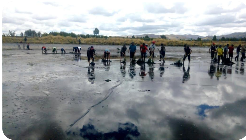
Figura 3.17: Limpieza del reservorio de geomenbrana Huarapite
