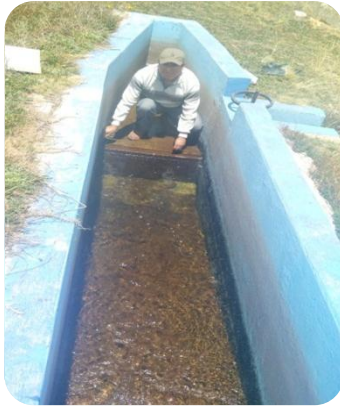
Figura 2.8: Cámara desarenador, para aforar por el método volumétrico
