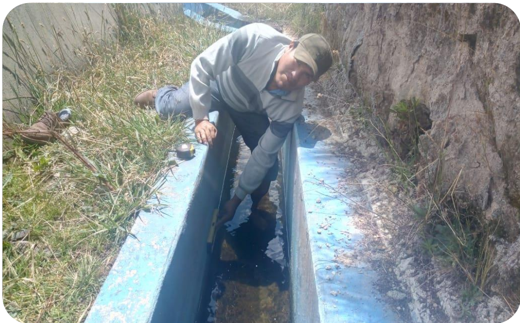
Vista 02: Medición de la pendiente, con nivel de mano en el canal de ingreso a tubería
