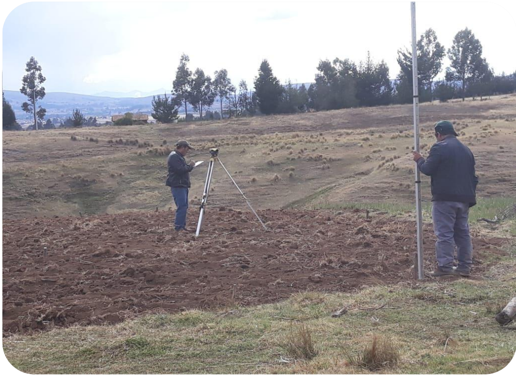
Vista 09: Nivelación y estacado de terreno para la prueba de avance
