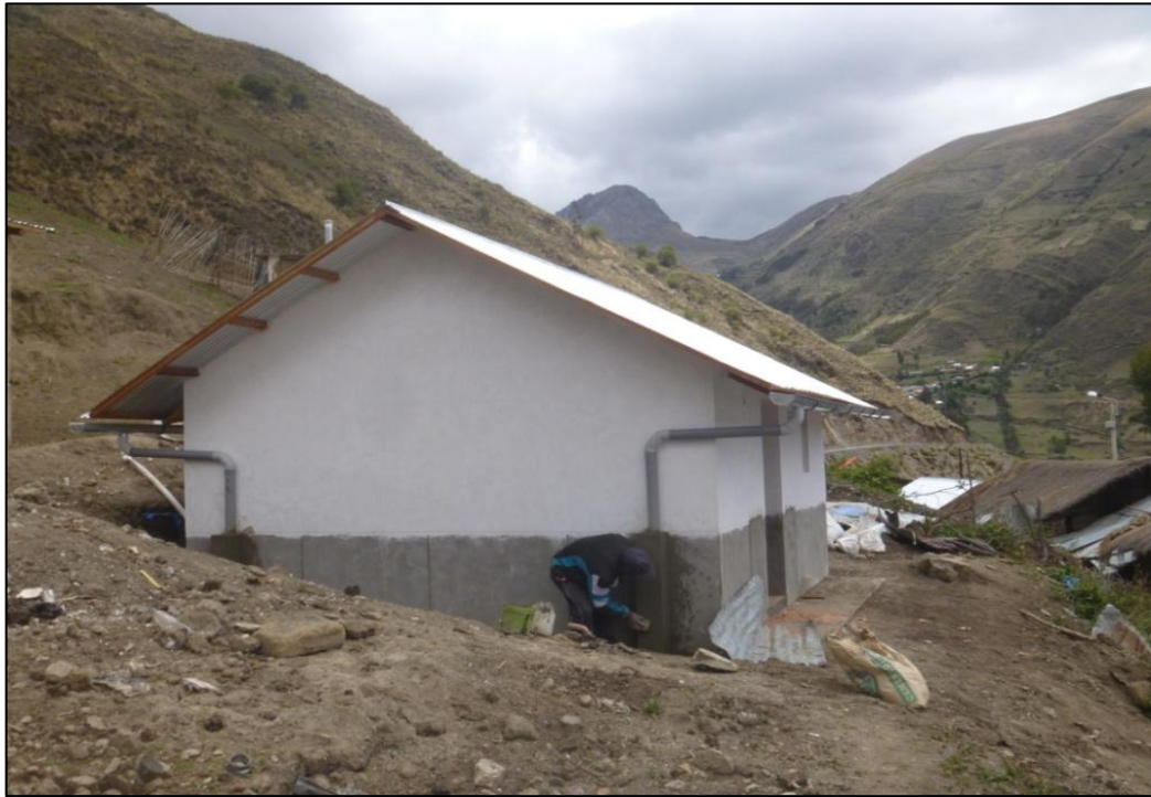
Foto 29. Vaciado dado de concreto – sistema de drenaje pluvial
