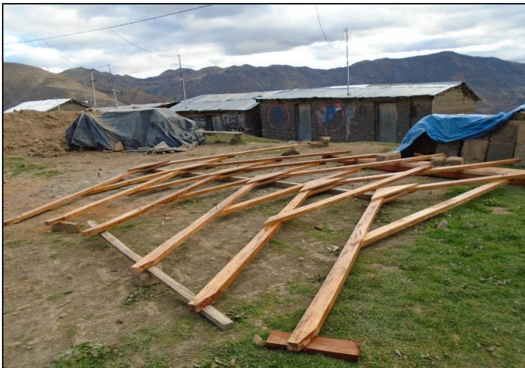
Foto 18. Habilitación de tijerales de 4"x2"x10' y 4"x2"x12' madera tornillo
