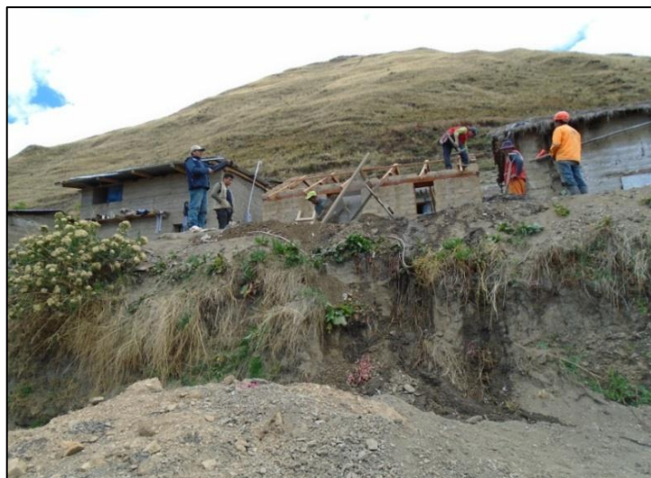
Figura 3.13. Instalación tijerales de 4"x2"x12' y 4"x2"x10' madera tornillo (II)
