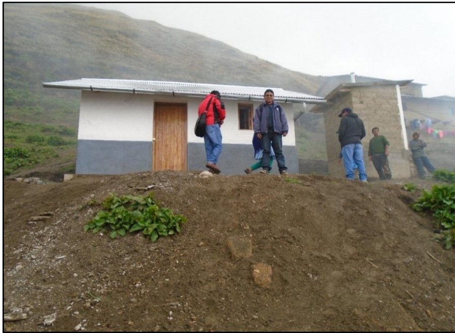
Figura 3.59. Vivienda rural concluida
