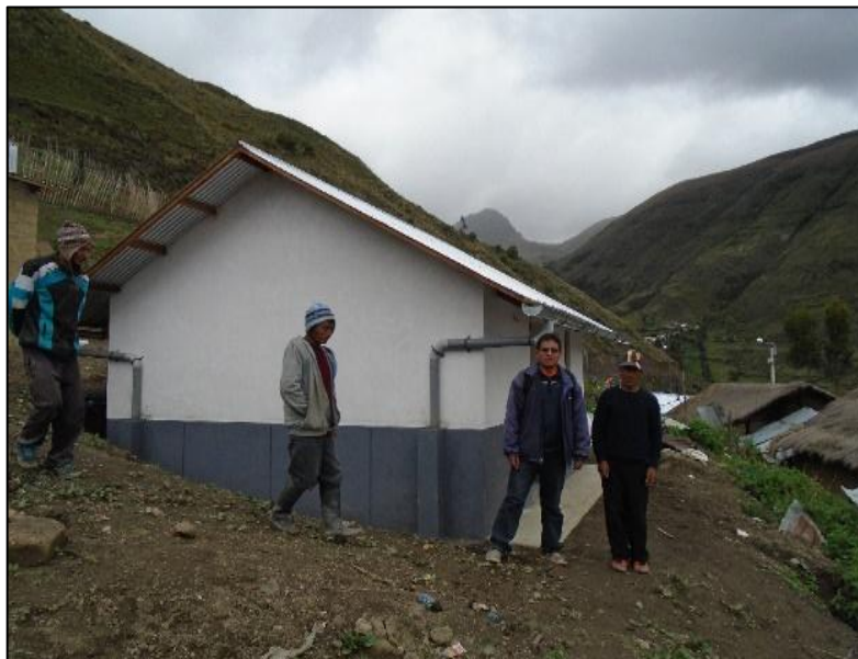
Figura 3.44. Vivienda terminada con drenaje pluvial
