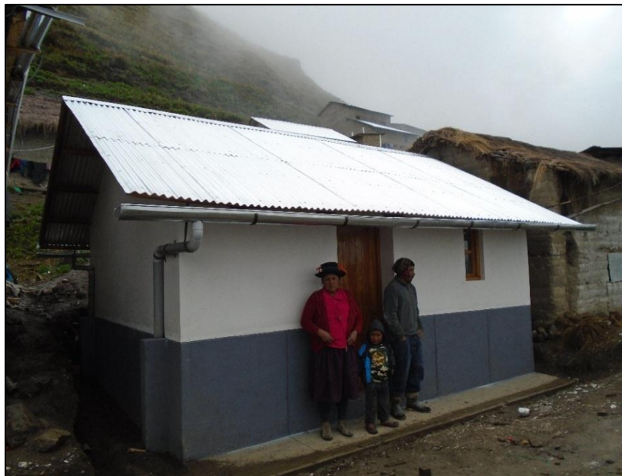
Figura 3.65. Vivienda construida por Programa Nacional Vivienda Rural
