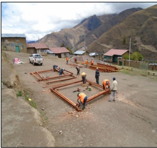
Figura 3.8. Habilitación de viga collarín
