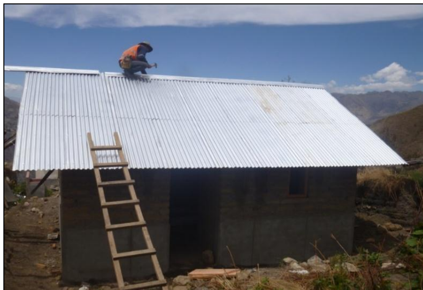
Figura 3.19. Colocación de cumbrera
