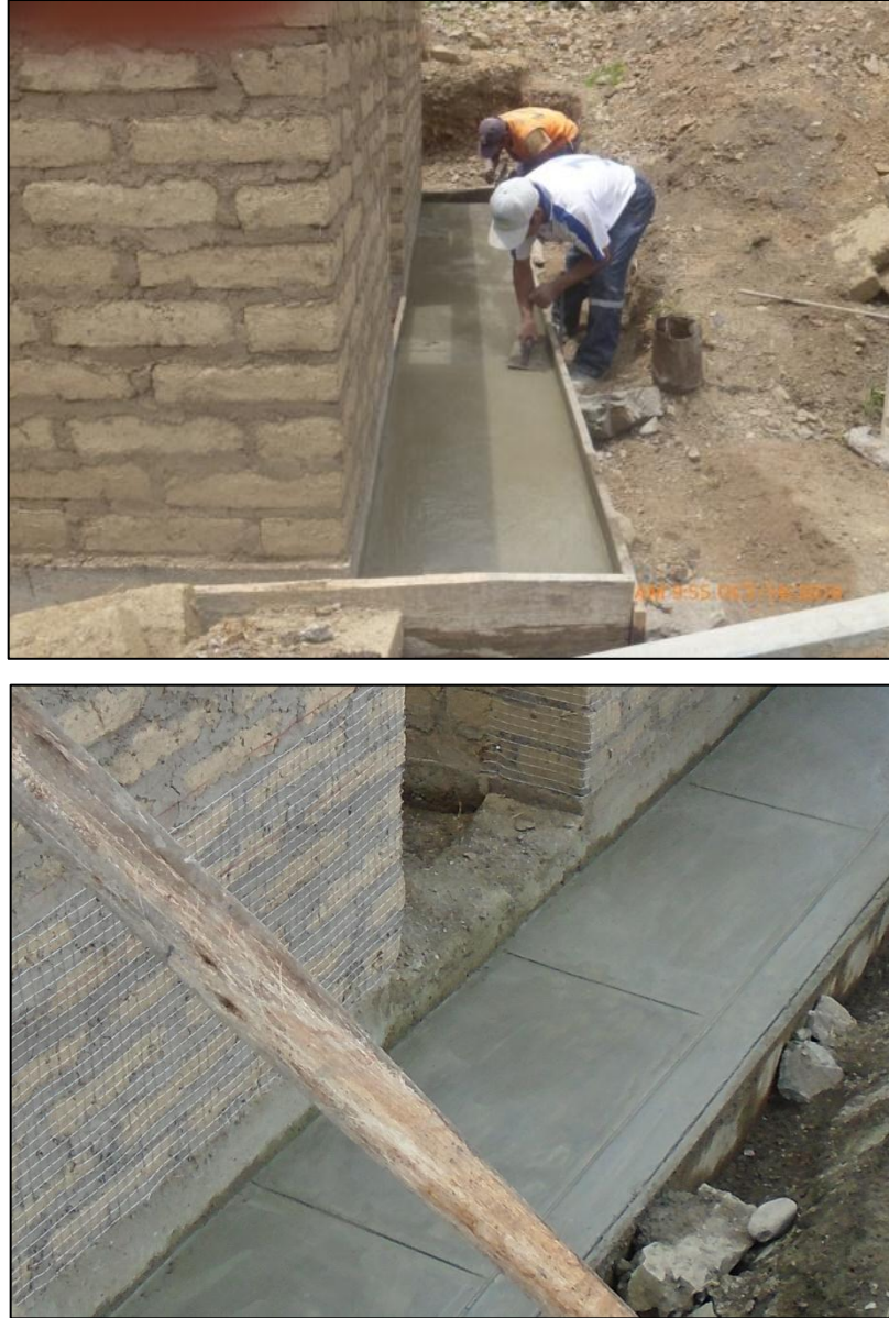
Figura 3.42. Construcción de vereda L=5.00 m. A=0.60 m. e=0.10 m
