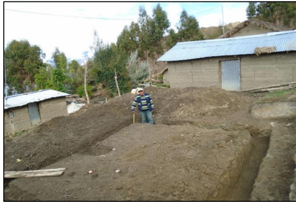
Figura 3.4. Excavación de zanja H=0.60 \text{ m.} A=0.40 \text{ m}
