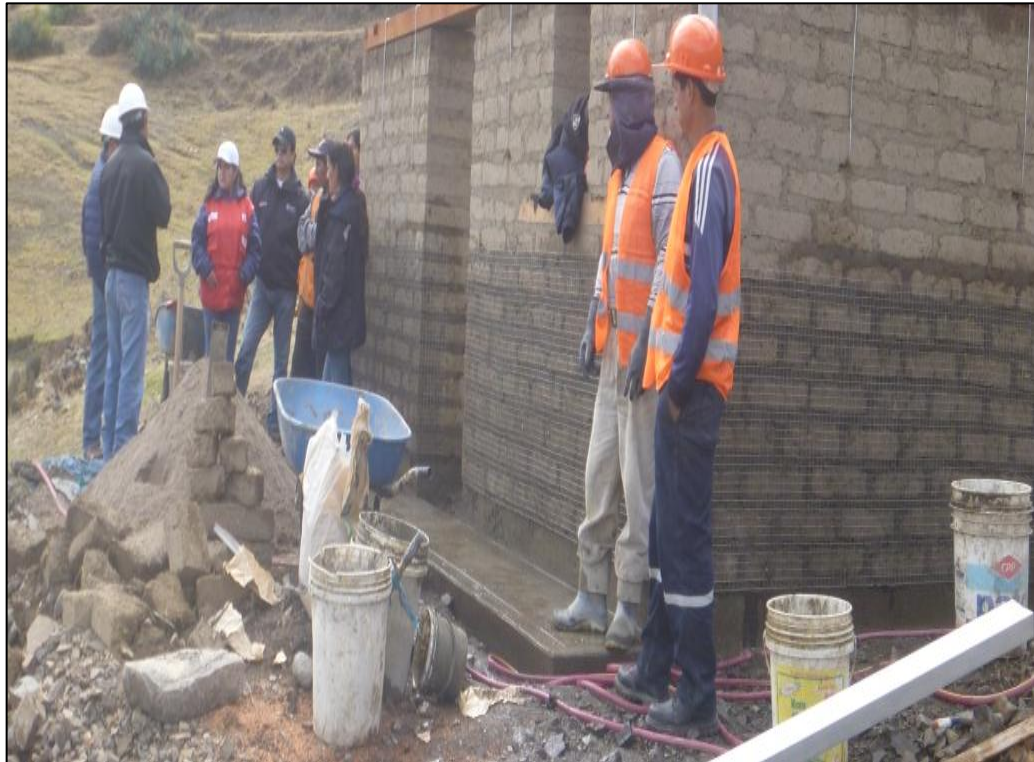
Foto 25. Enmallado de muro para tarrajeo zócalo
