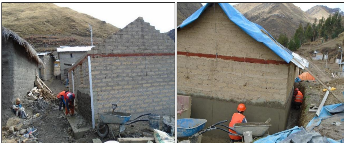
Figura 3.26. Tarrajeo de zócalo h=0.90 m
