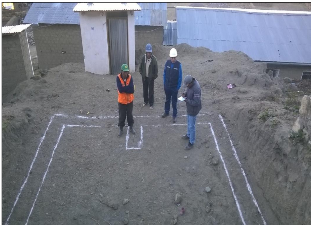
Foto 4: Trazo y replanteo preliminar dimensión de 5.00 m. x 4.40 m
