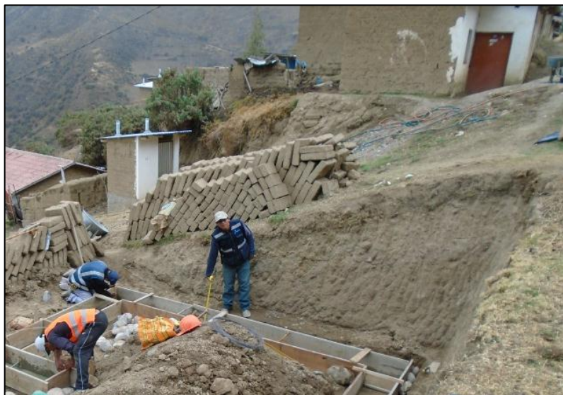
Figura 3.6. Encofrado sobrecimiento h=0.25 m
