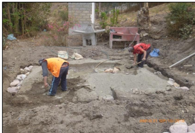
Figura 3.5. Construcción de cimiento corrido
