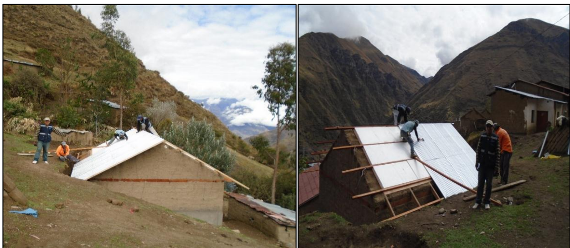
Figura 3.17. Colocación de planchas de calamina galvanizado de 0.80 m. x 1.80 m
