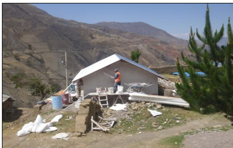
Figura 3.28. Enlucido exterior de la vivienda
