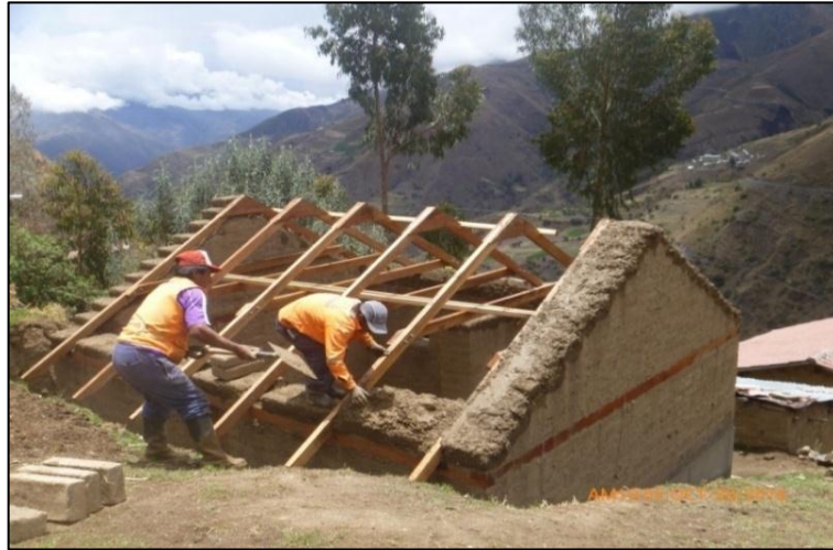
Figura 3.25. Relleno de muro y de tímpanos
