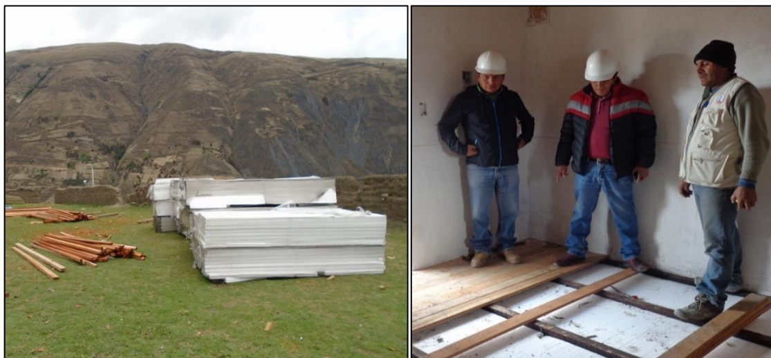
Figura 3.37. Paquetes de tecnopor – colocación de tecnopor D=20
