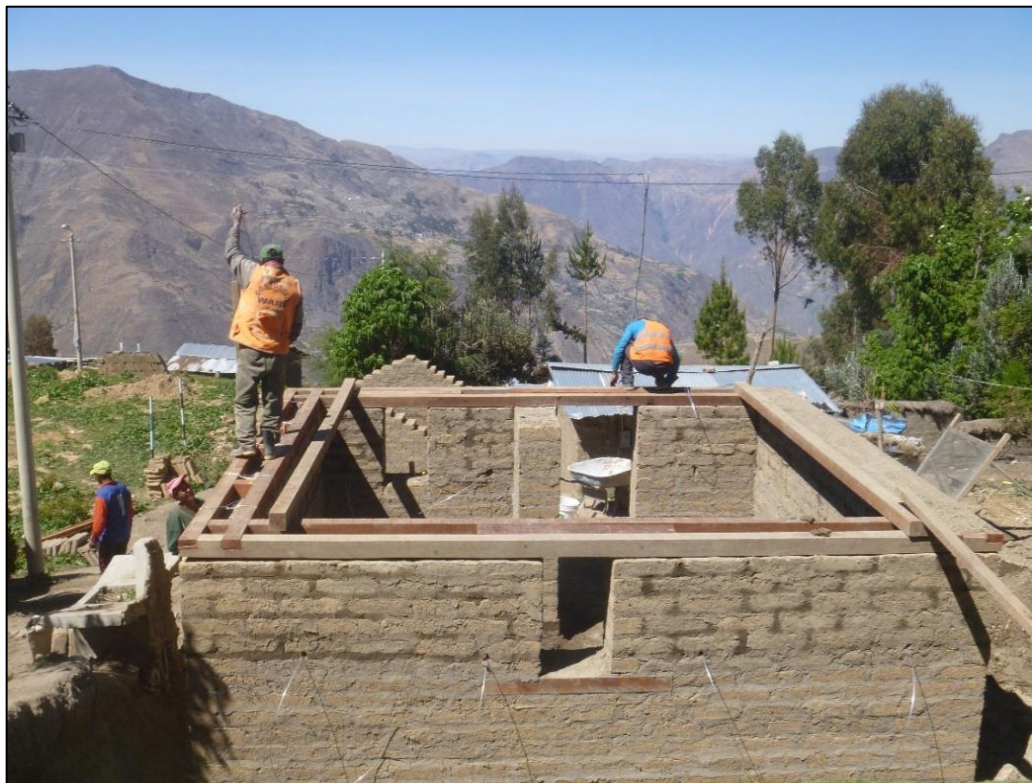
Foto 16. Colocación de viga collar y dinteles para puerta y ventanas
