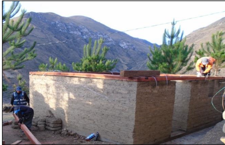
Figura 3.23. Relleno de viga collar
