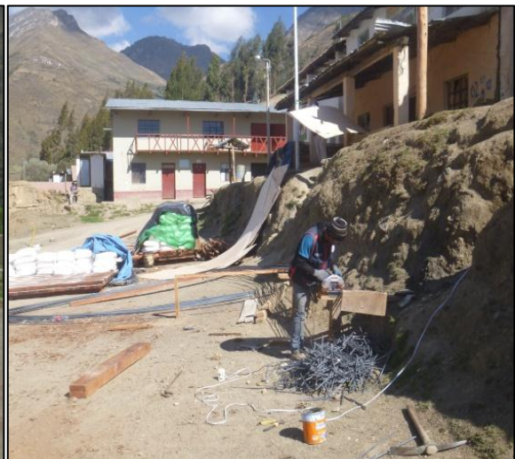
Figura 3.35. Habilidadón de estacas de fierro
