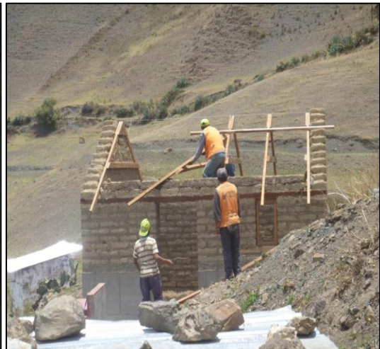
Figura 3.12. Instalación de tijerales (I)
