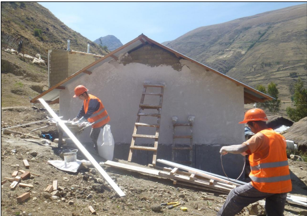
Foto 28. Enlucido de muro exterior con yeso
