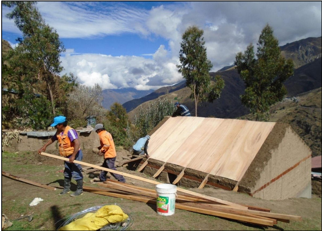
Foto 21. Colocación de triplay de 4mm
