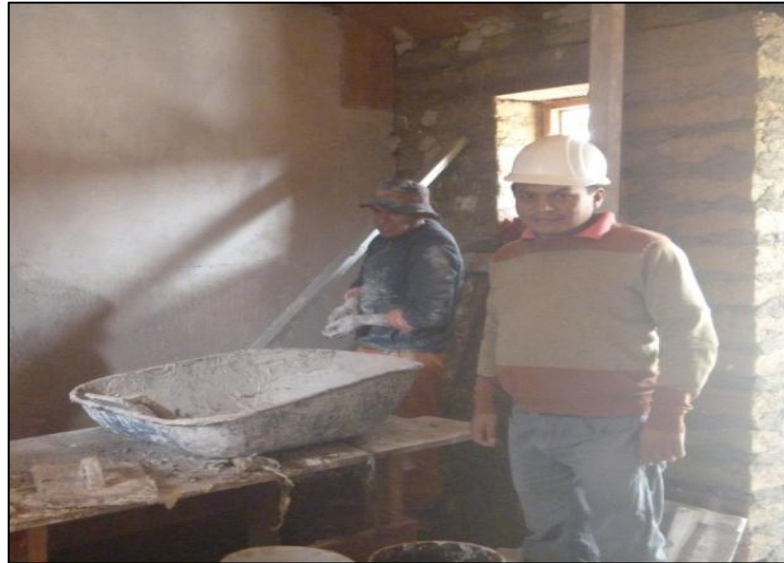
Figura 3.27. Enlucido interior de la vivienda
