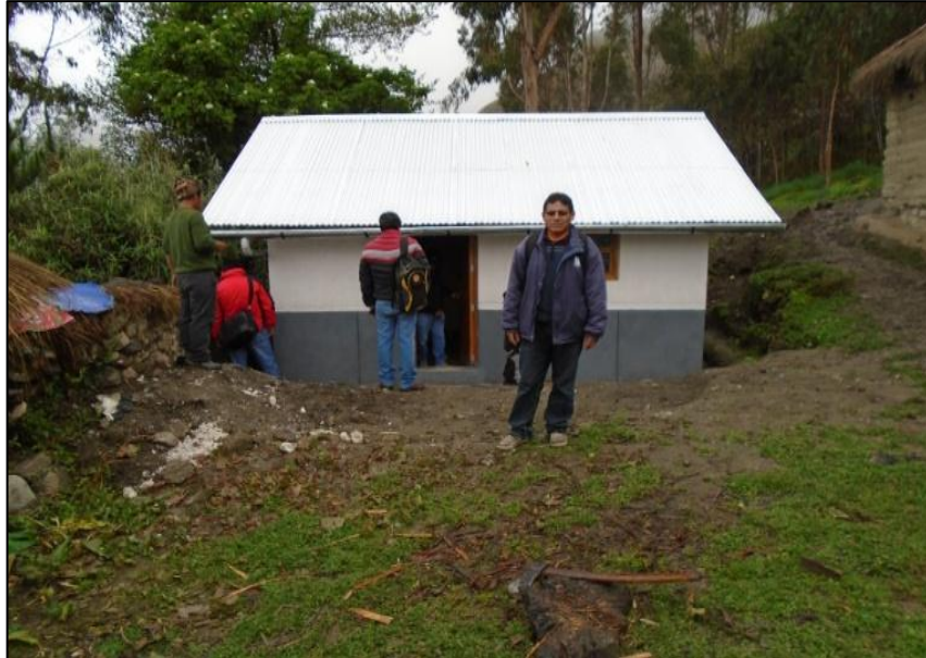
Figura 3.18. Cobertura con calaminas
