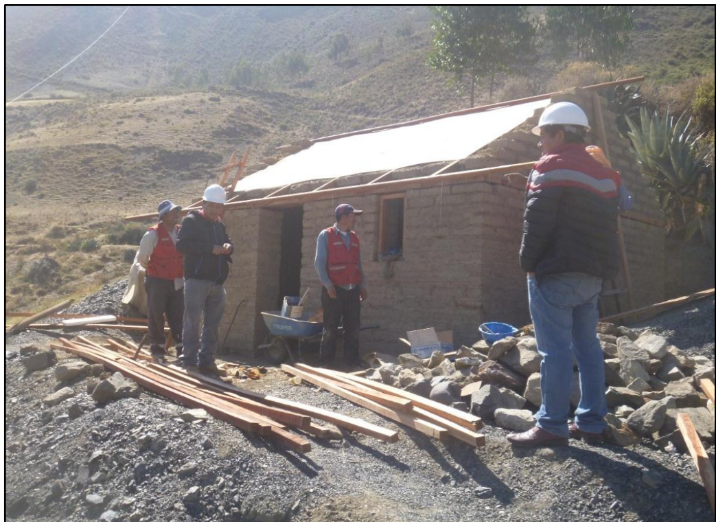
Foto 22. Instalación de correas 2"x2"x10' y 2"x2"x12' madera copaiba
