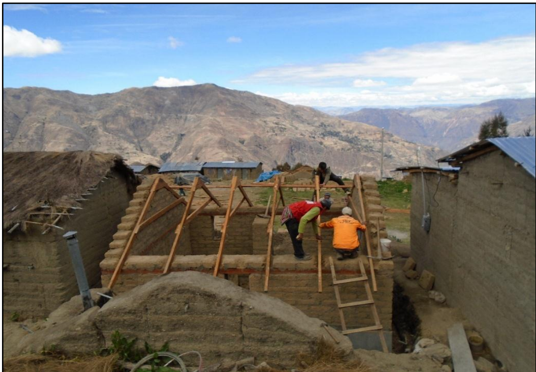
Foto 20. Instalación de los tijerales
