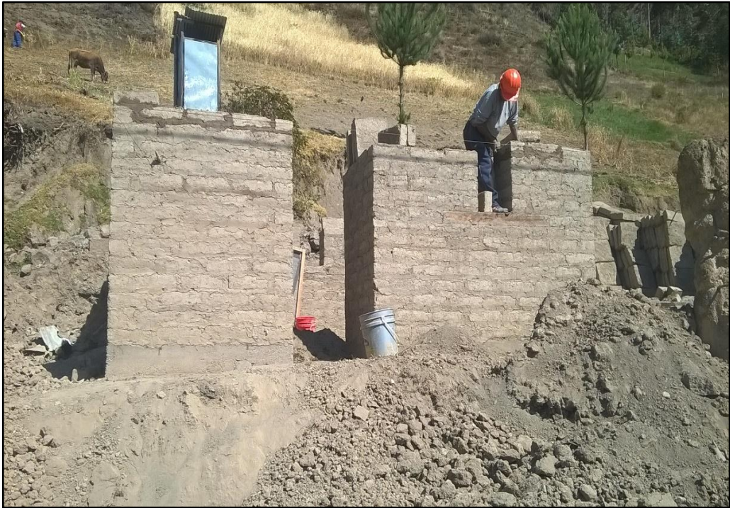
Foto 13. Asentado de muro de adobe
