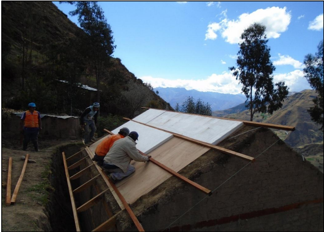
Foto 23. Colocación de tecnopor poliestireno habilitado de 2" D=20
