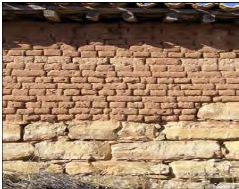
Figura 1.3. Muro de adobe sobre basamento de piedra
