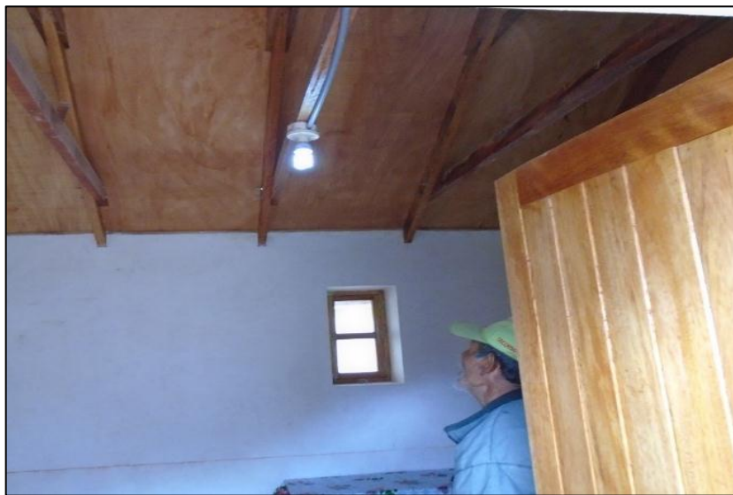
Figura 3.45. Prueba de energía eléctrica vivienda 01
