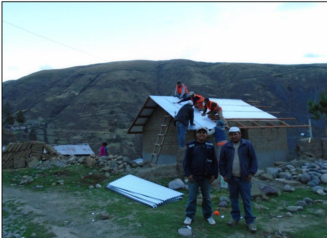
Foto 24. Techado de la vivienda
