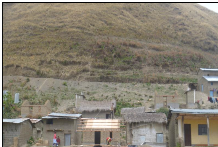
Figura 3.15. Colocación de las correas 2"x2"x12' y 2"x2"x10'
