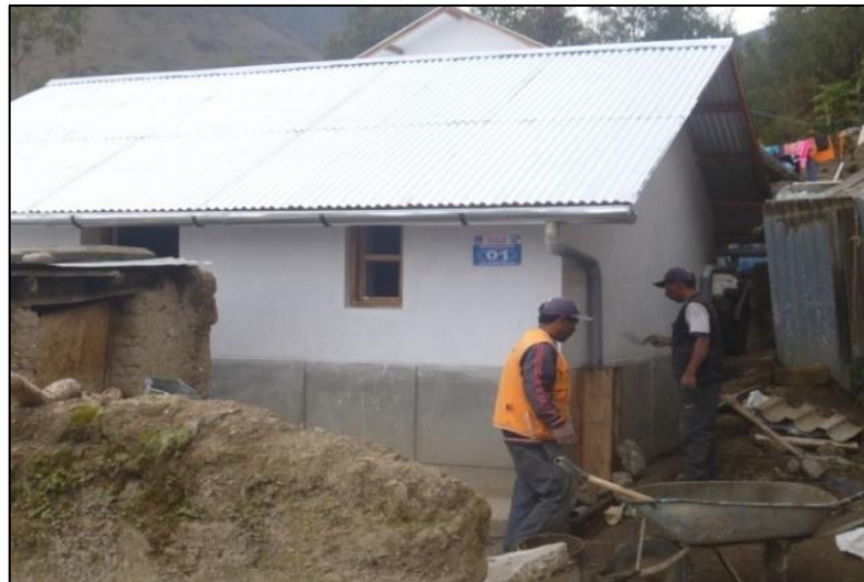
Figura 3.43. Instalación de canaletas y vaciado dado de concreto
