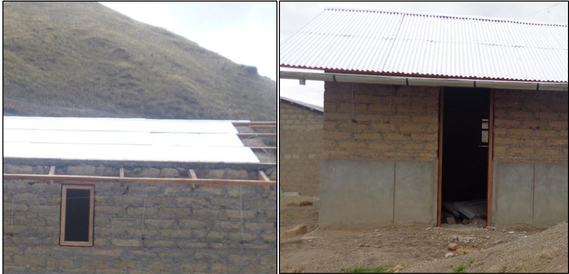
Figura 3.31. Instalación de marcos para ventanas y puerta
