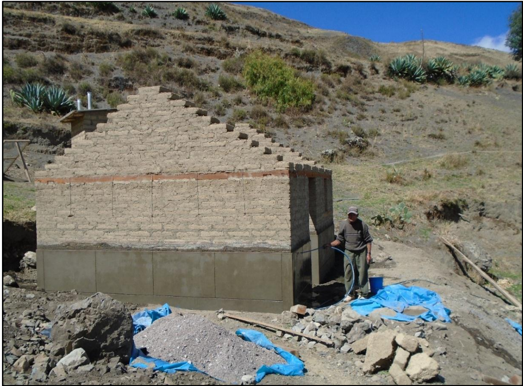
Foto 27. Curado del zócalo
