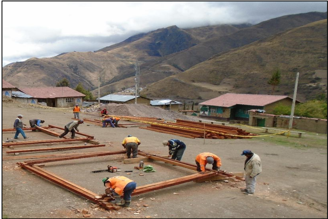
Foto 15. Habilitación de viga collar 4"x4"x10' y 4"x4"x12'
