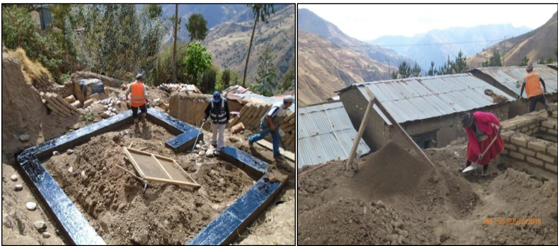
Figura 3.20. Capa aislante con asfalto líquido
