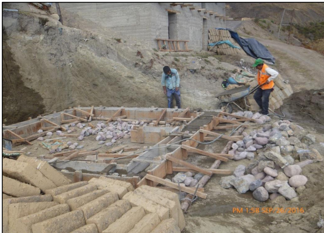
Foto 8. Vaciado de sobrecimientos h=0.25m . Mezcla 1:8 + 25 % P.M
