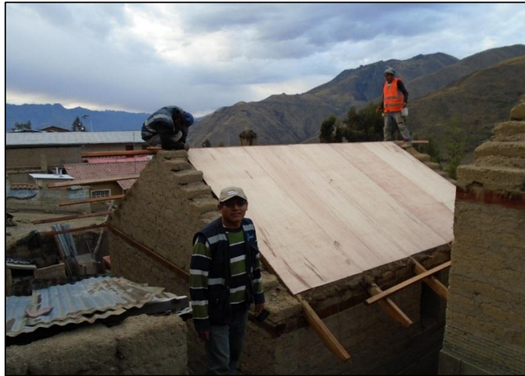
Figura 3.14. Instalación de triplay de 4 mm
