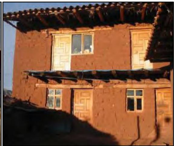
Figura 1.10. Vivienda de adobe de la sierra
