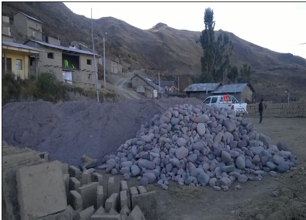
Foto 2: Materiales en cancha para la ejecución de la partida cimiento corrido mezcla 1:12 + 30 % P.G (manual), concreto sobrecimiento mezcla 1:8 + 25% P.M
