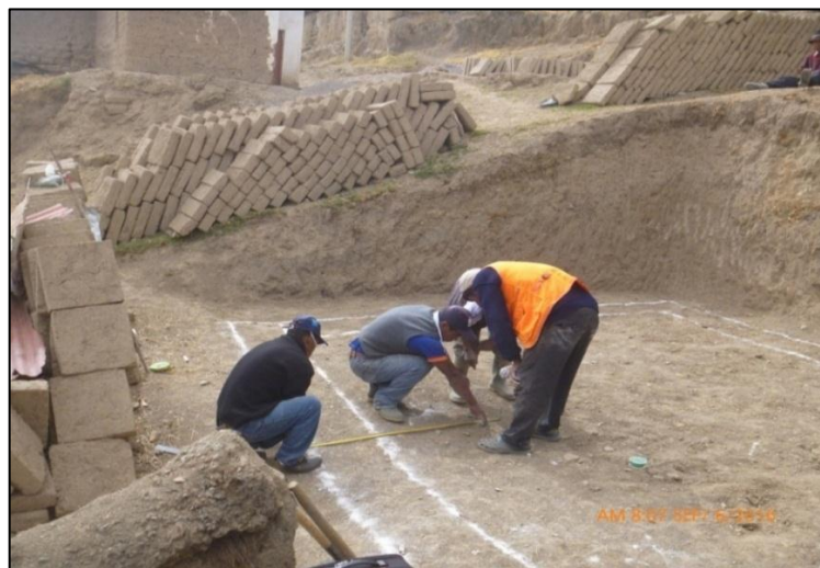
Figura 3.3. Trazo, nivelación y replanteo dimensión de 5.00 m. x 4.40 m
