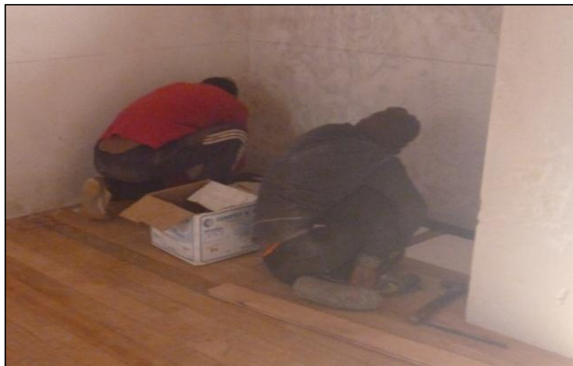
Figura 3.39. Colocación de rodones de 1”x1”x3 m
