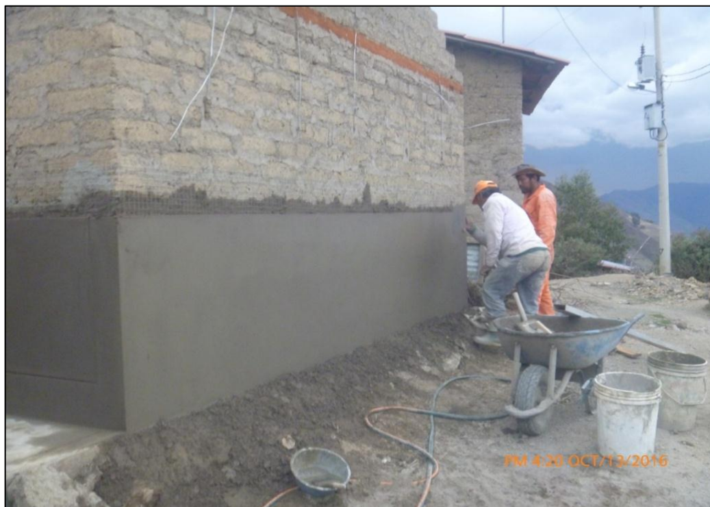
Foto 26. Tarrajeo de zócalo H=0.90m
