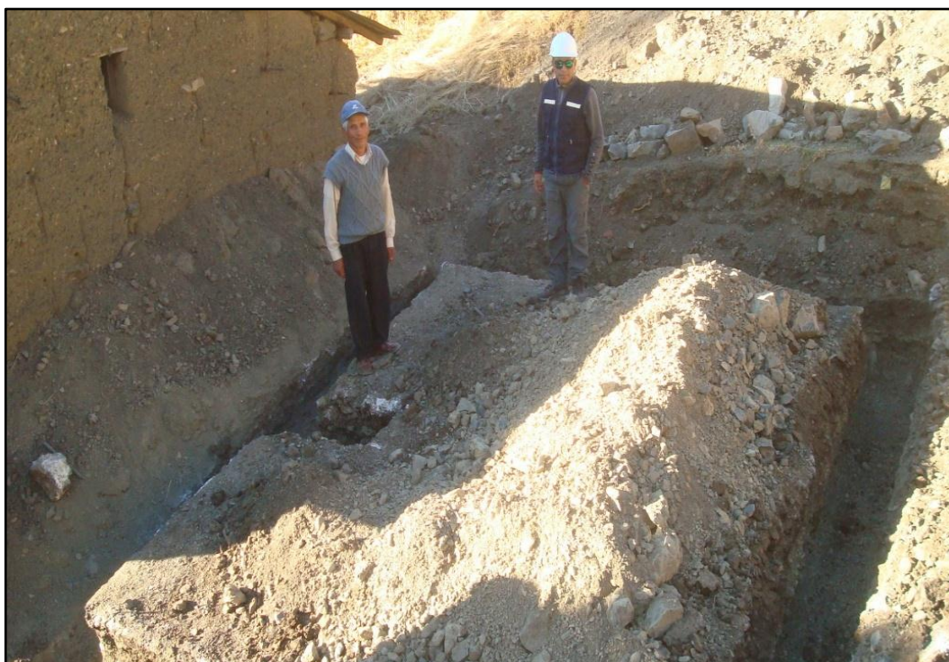
Foto 5. Excavación de zanja H=0.60m A=0.40m
