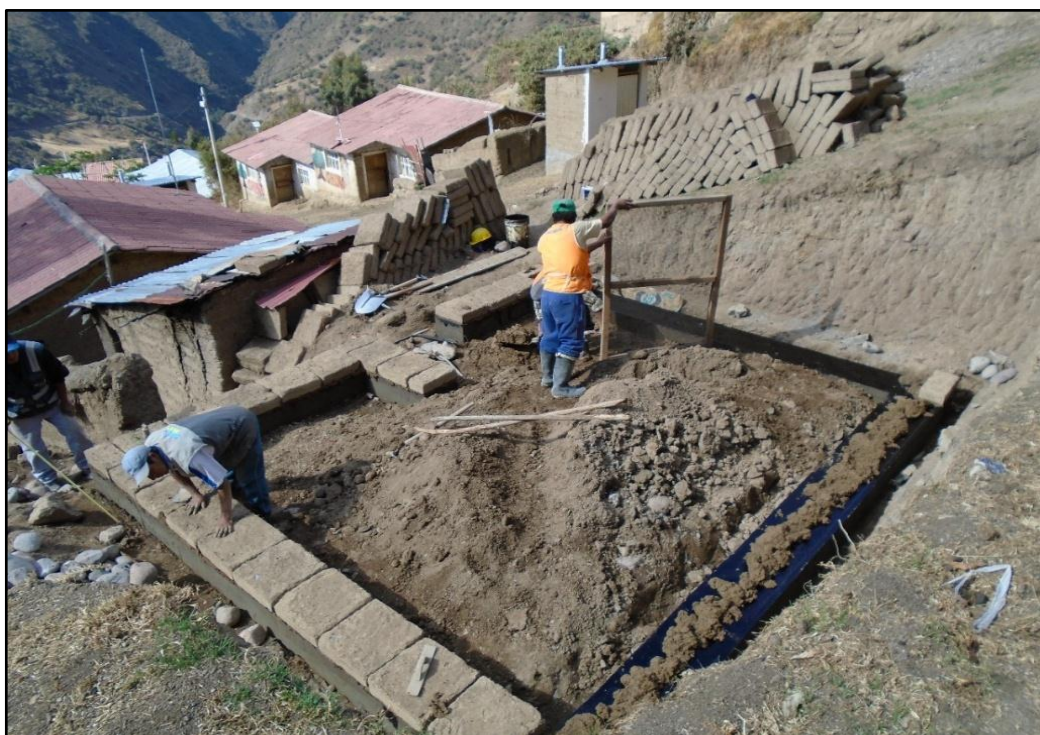
Foto 12. Asentado muro de adobe fila impar - primera hilada
