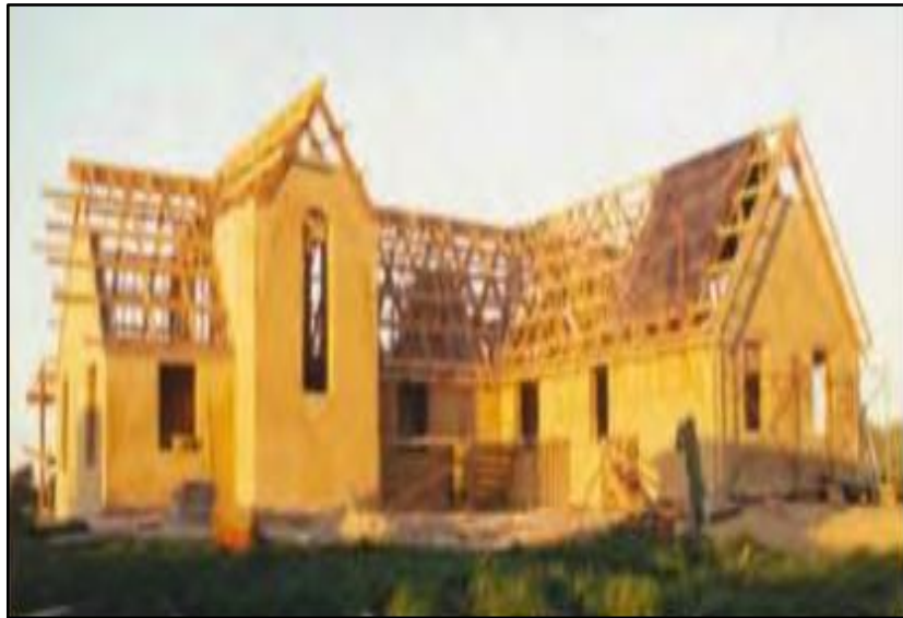
Figura 1.1. Vivienda en Otorohonga, Nueva Zelanda
