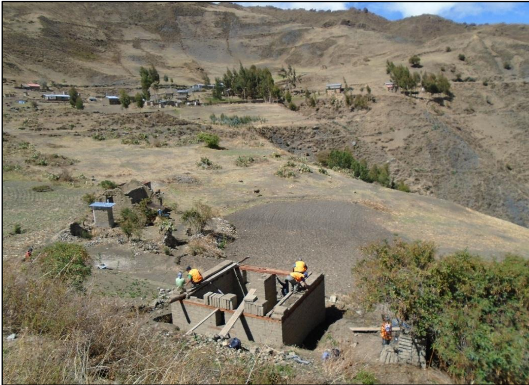
Foto 17. Asentado de adobe de los muros - tímpanos
