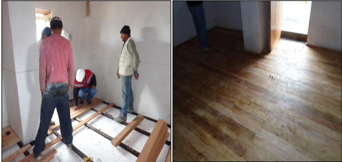
Figura 3.38. Instalación de madera machihembrado
