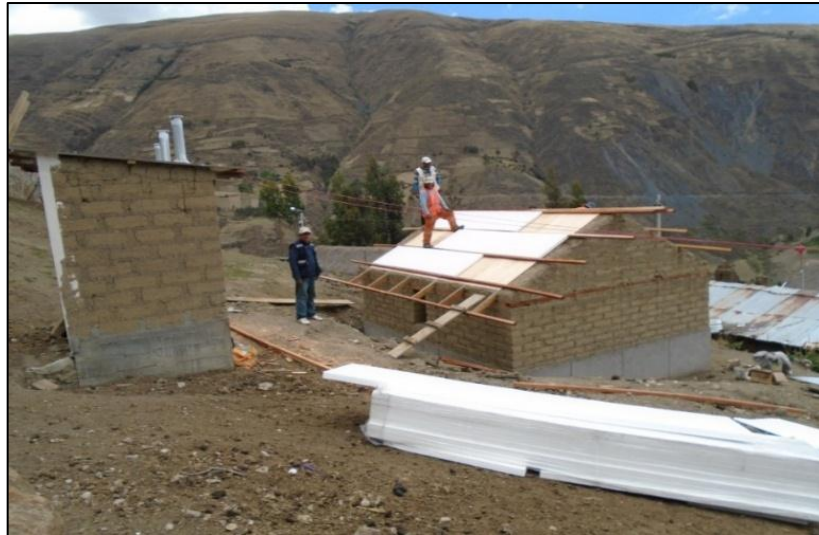
Figura 3.16. Colocación de tecnopor poliestireno habilitado de 2" D=20
