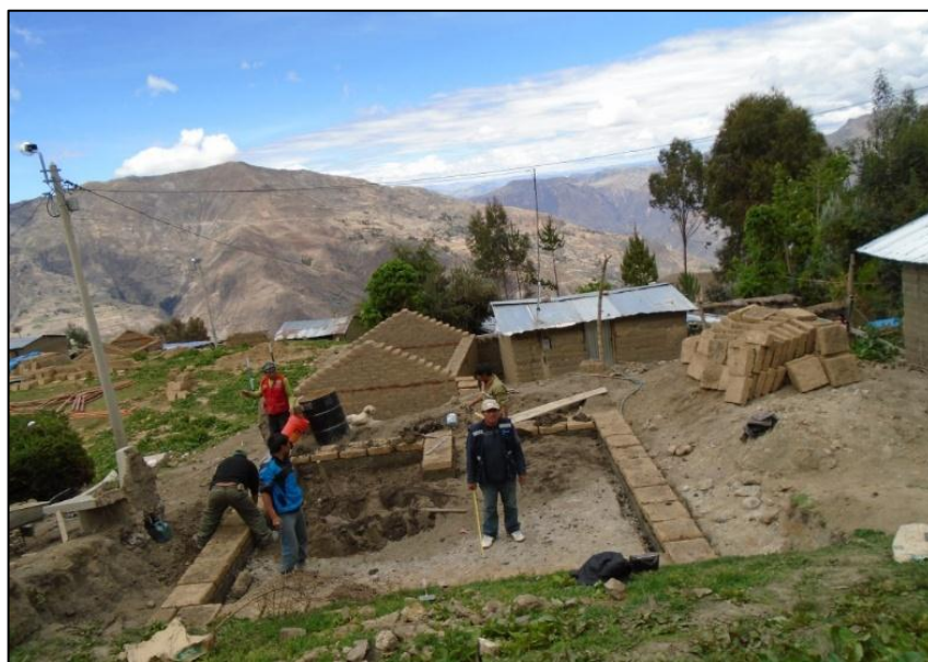
Figura 3.22. Asentado muro de adobe
