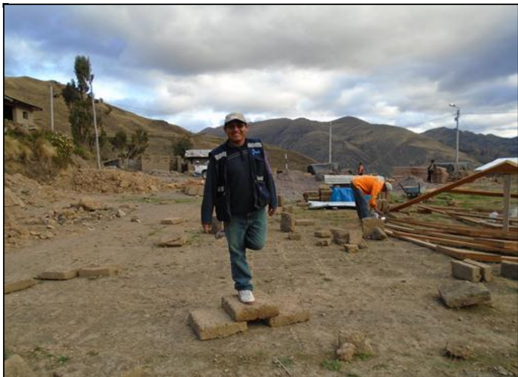
Foto 10. Prueba de resistencia de adobe
