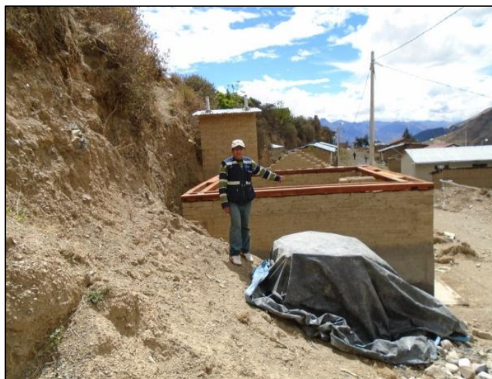
Figura 3.10. Colocación de viga collar 4"x4"x10' y 4"x4"x12' (II)
