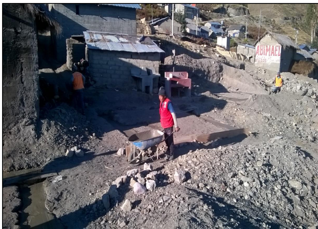
Foto 6. Vaciado de cemento corrido mezcla 1:12 + 30 % P.G
