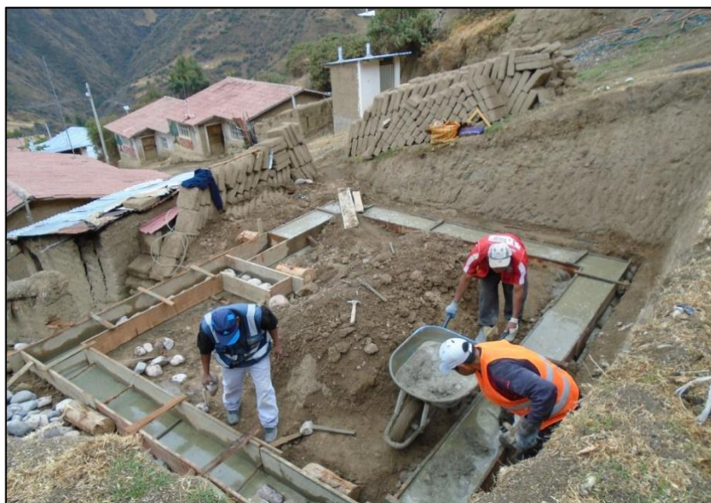
Figura 3.7. Vaciado de sobrecimiento
