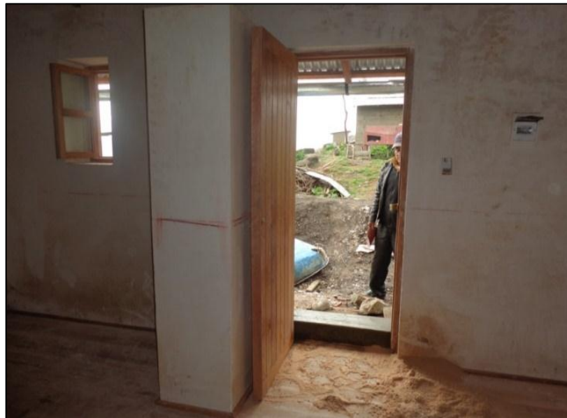
Figura 3.40. Instalación de puerta (0.80 m. x 1.96 m.) y ventanas (0.40 m. x 0.74 m.)
