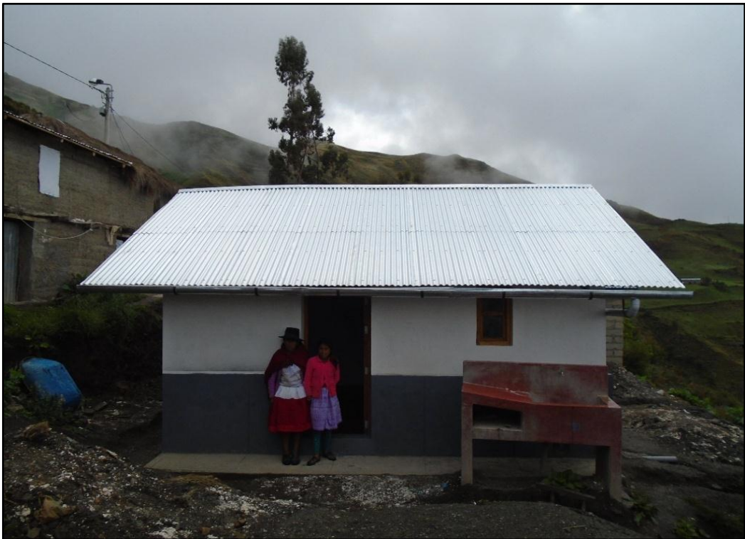
Foto 32. Vista frontal de la vivienda concluida
