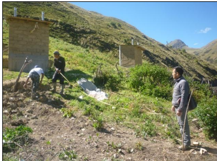
Figura 3.2. Limpieza de terreno
