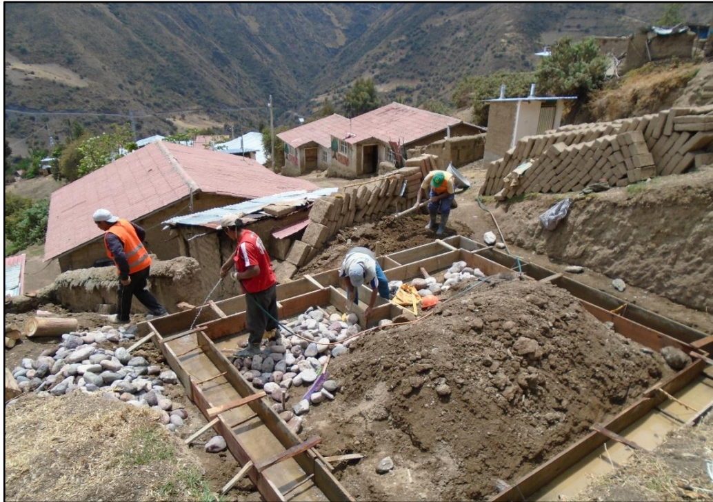
Foto 7. Encofrado de sobrecimiento
