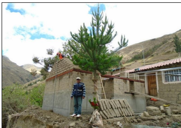
Figura 3.24. Asentado muro de adobe (Tímpanos)
