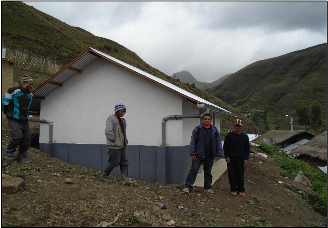
Foto 31. Vista lateral de la vivienda terminada
