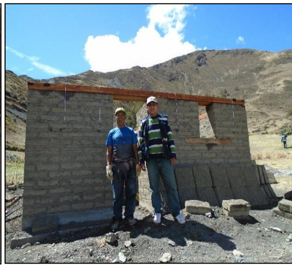
Figura 3.9. Colocación de viga collar (I)
