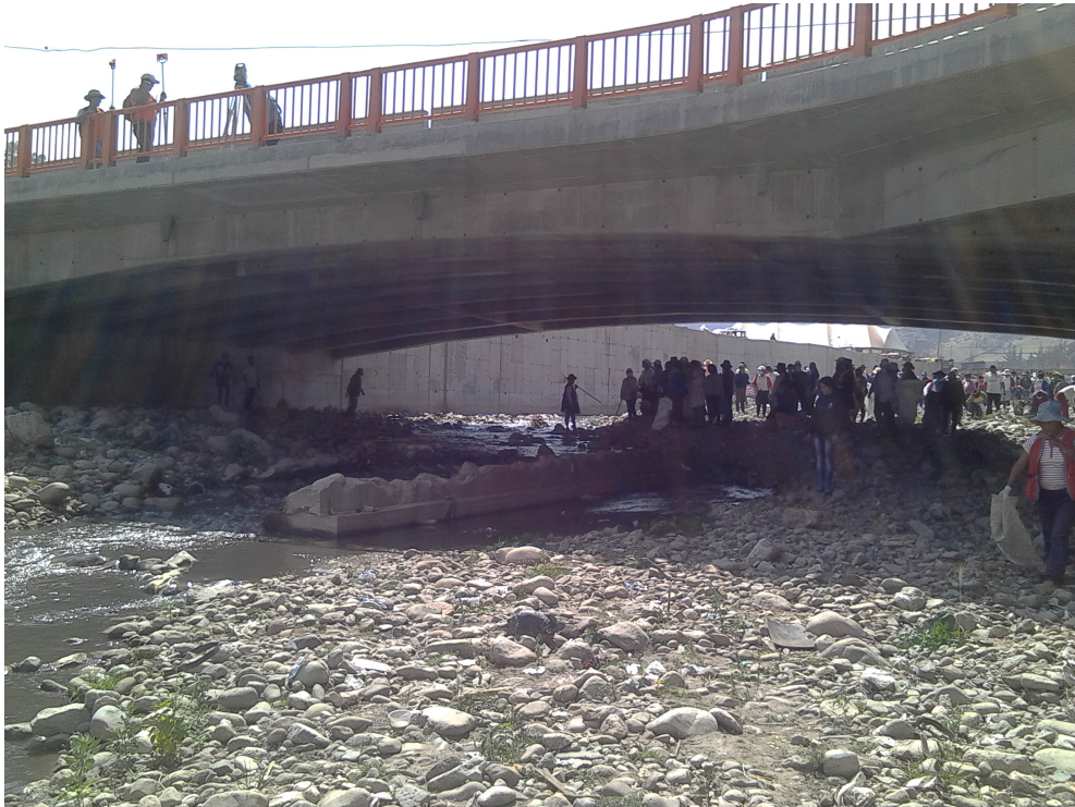
Vista panorámica del puente Poshcota en épocas de estiaje
