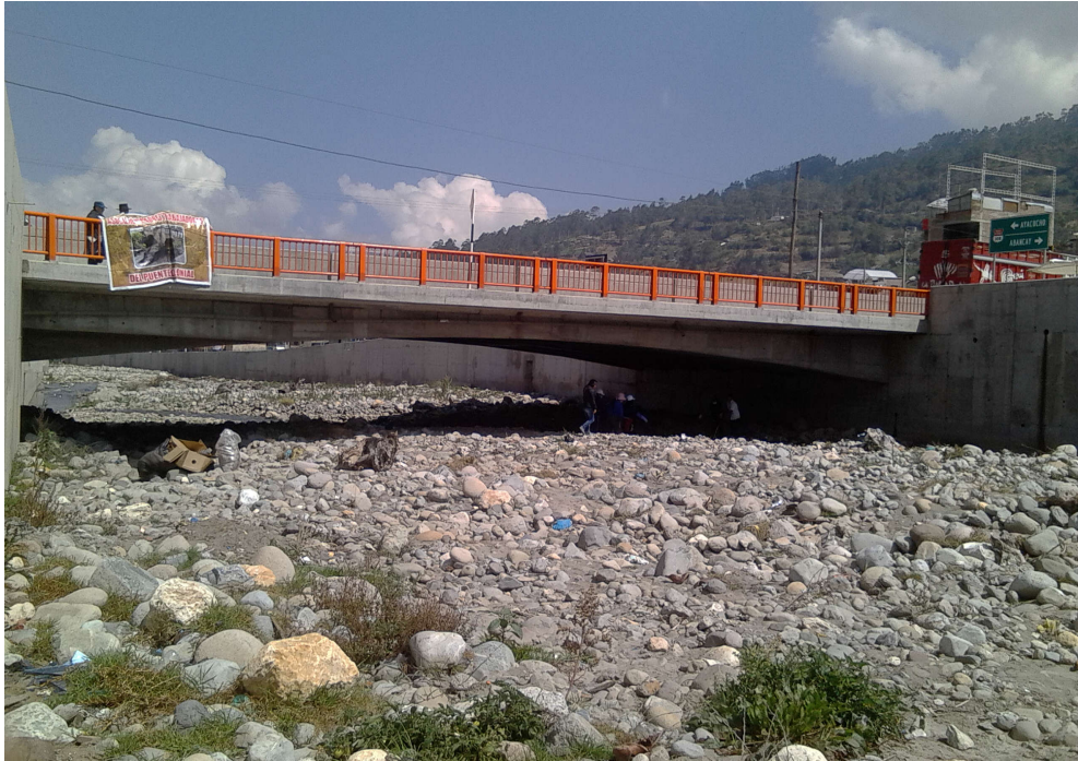
Vista panorámica del puente Poshcota en épocas de estiaje
