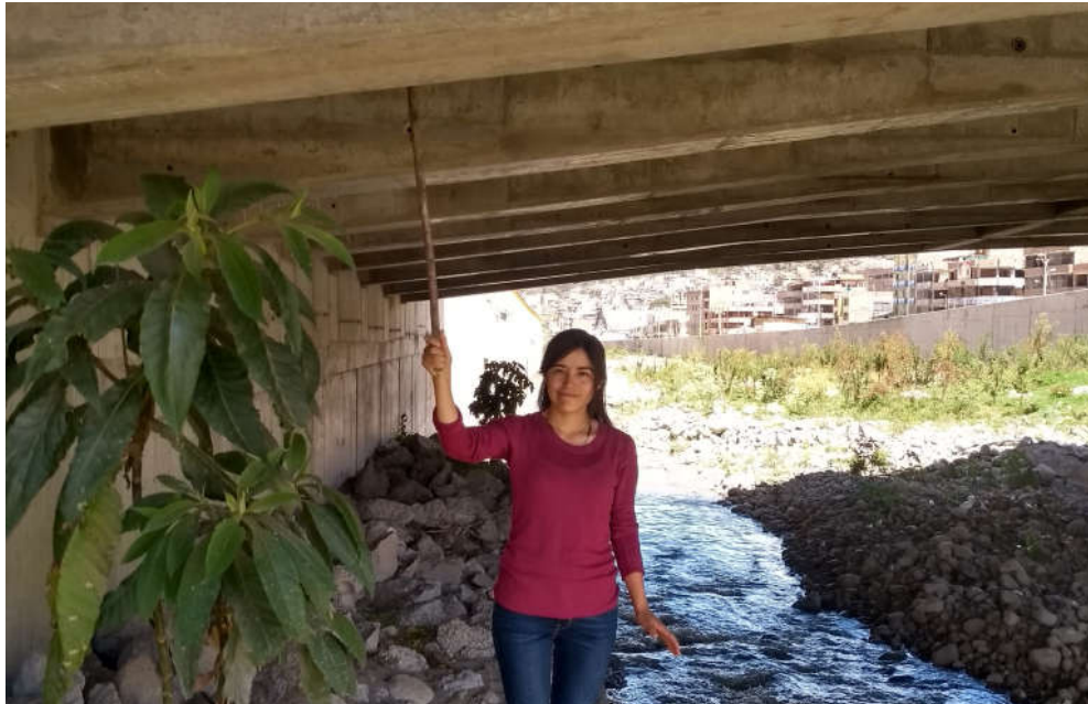
Trabajos de campo en el puente Poshcota del río Chumbao
