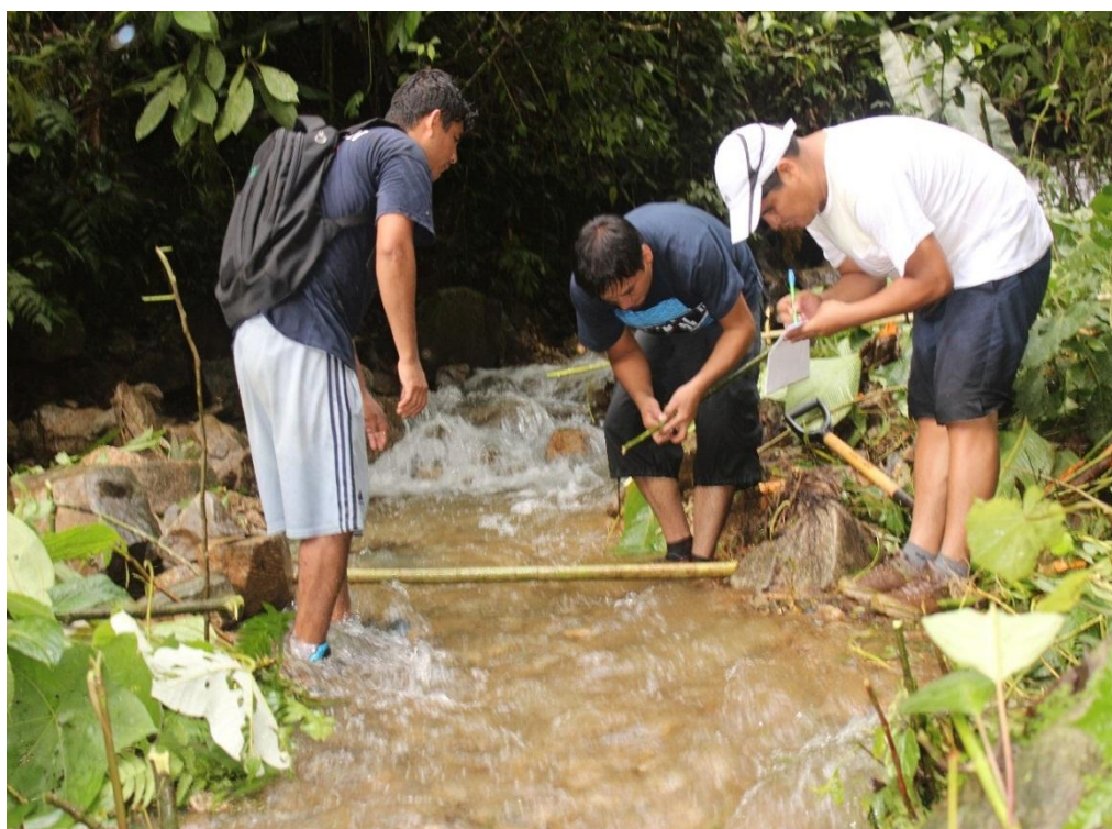
Fotografía 2. Seccionamiento para el aforo de la futura captación
