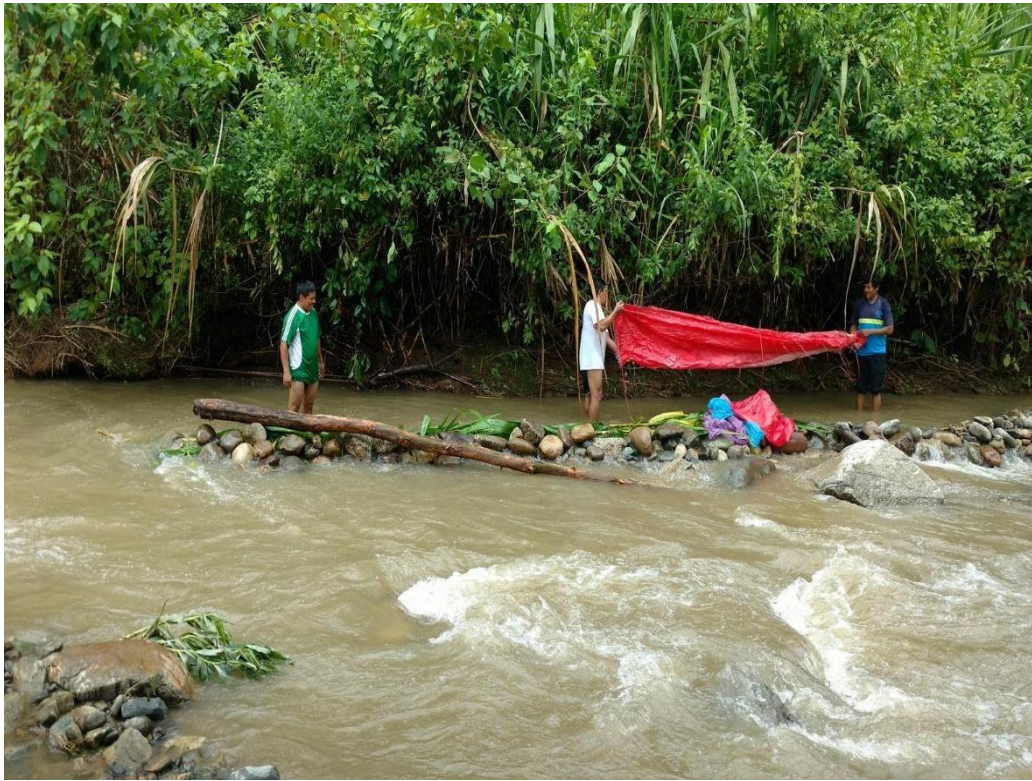
Fotografía 10. Captación de agua potable para Canayre.
