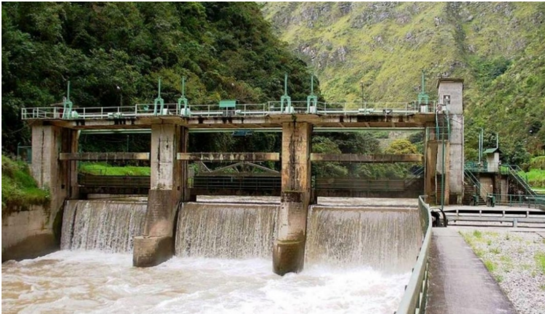
Figura 2.1: Bocatoma con barraje Móvil(C.H.Machupicchu)
