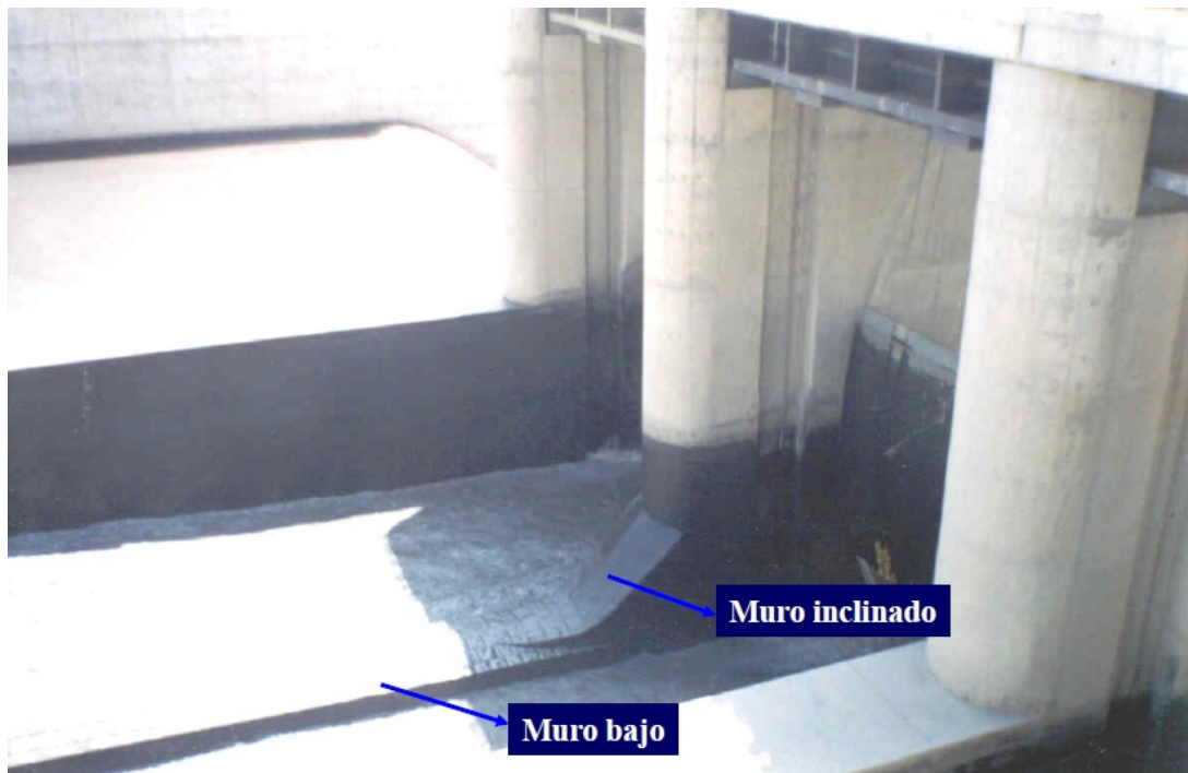
Figura 2.11: Perfil hidrodinámico colocado en prototipo
