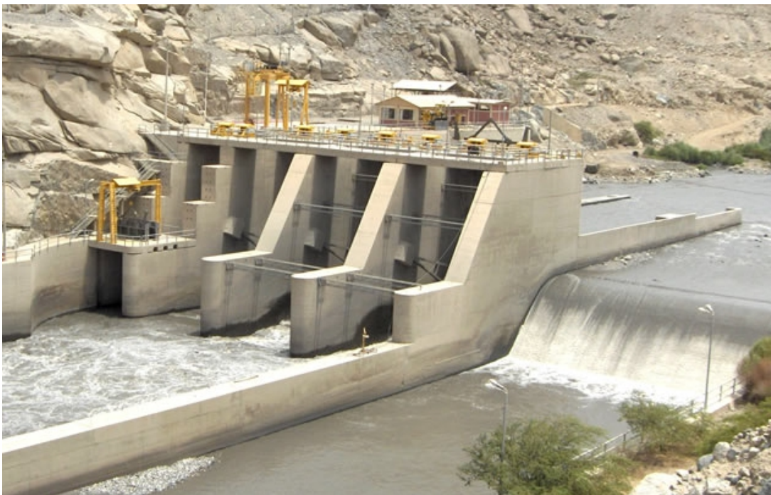
Figura 2.2: Bocatoma con barraje mixto(Chavimochic)
