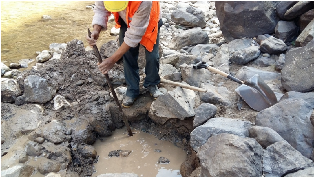
Figura 3.29: Excavación y selección de piedras en la orilla del río en un área de 1mx1m
