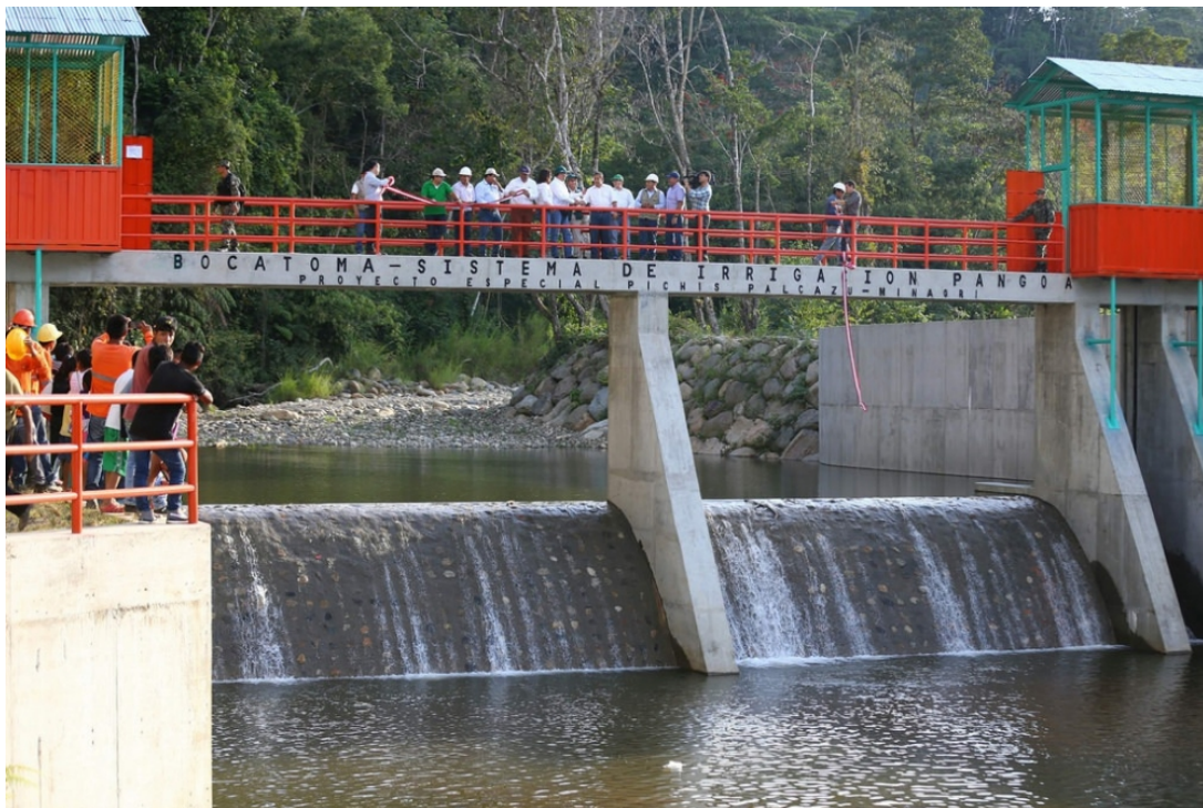
Figura 2.3: Captación tipo partidor(Bocatoma san Ramón)
