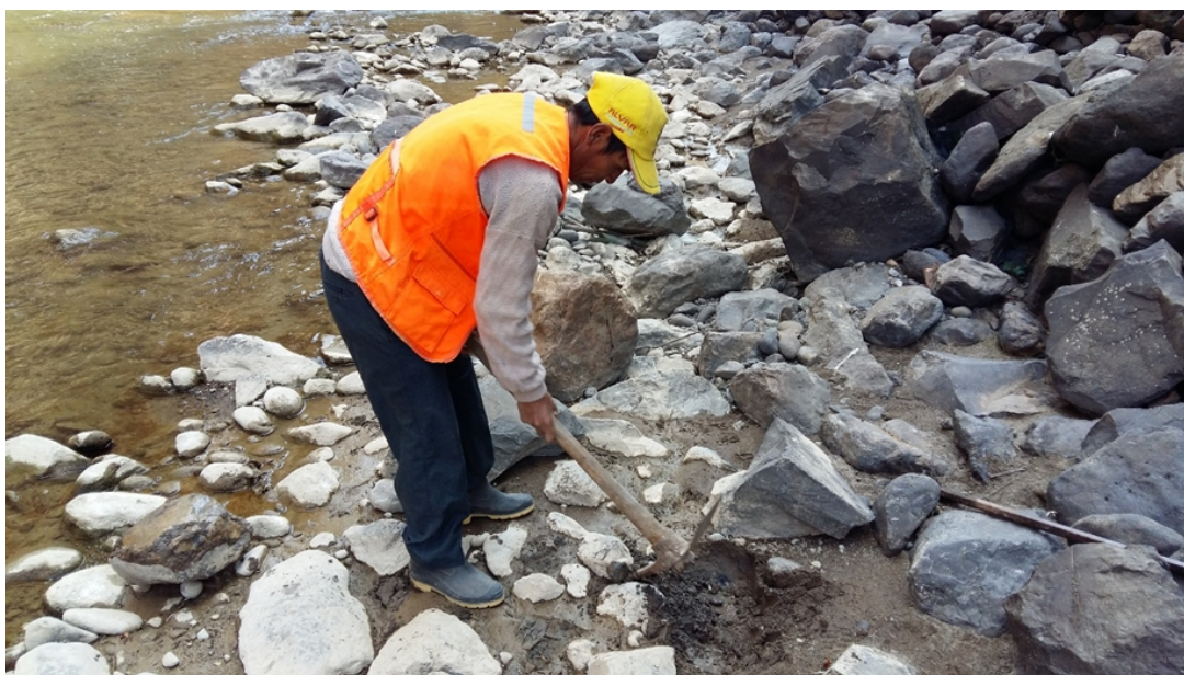
Figura B.5: Realizando una calicata en el eje de la bocatoma Urubamba
