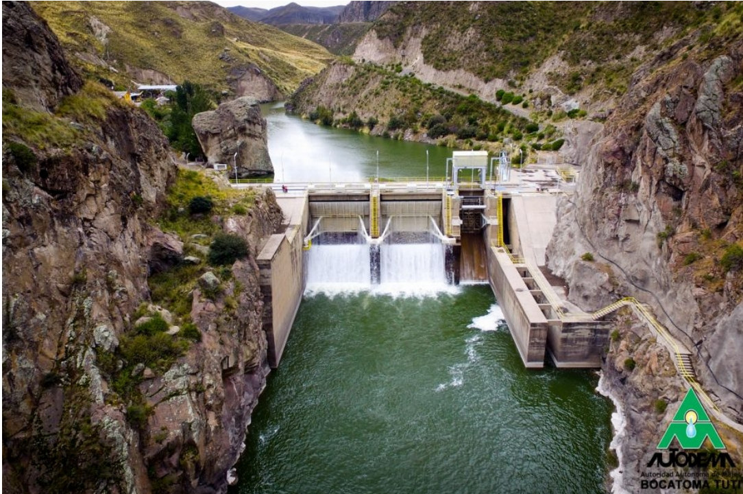
Figura 2.4: Captación con cambio de régimen(Bocatoma Tutti)
