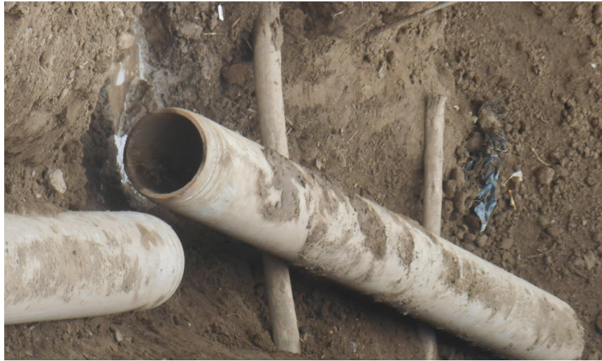
Figura C.5: vista de tuberías para su posterior sustitución.
