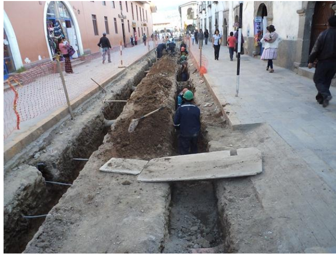
Figura C.8: Sustitución de un tramo de tuberías de agua potable por antigüedad de instalación.
