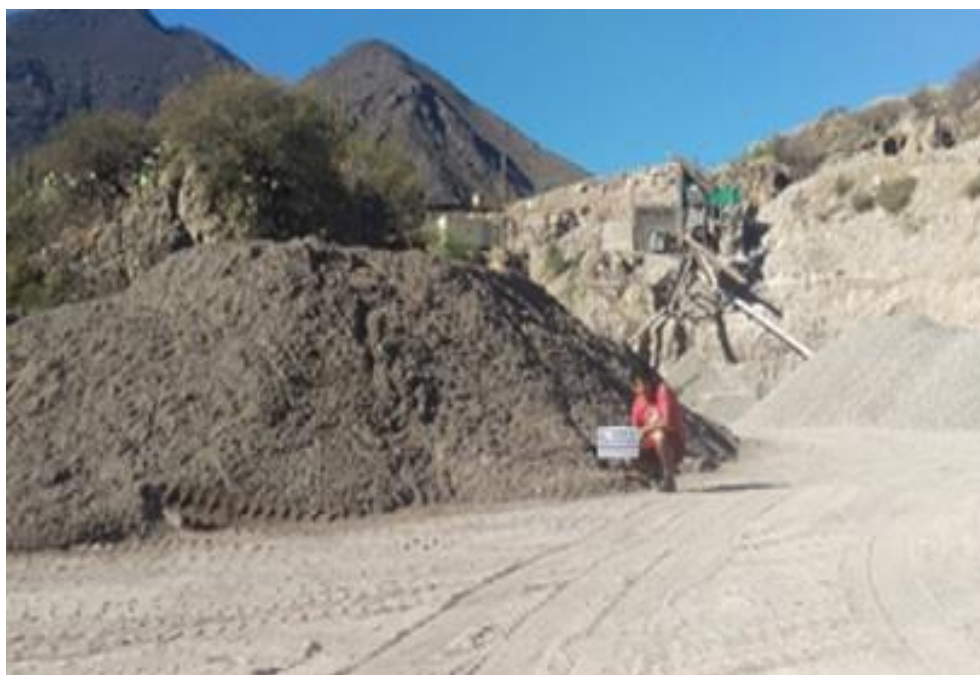
Figura 3.7: Extracción de agregado fino de la cantera de Accomachay.
