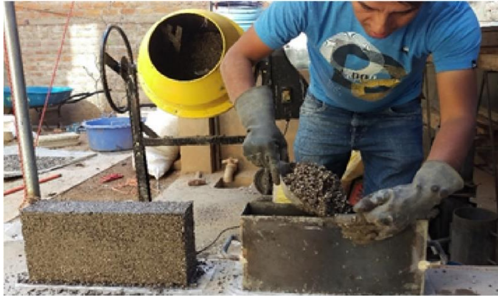
Figura 3.40: Llenado de mezcla al molde.
