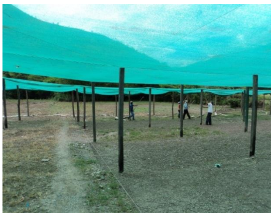
Foto 20. Tendido de malla rashell sobre tinglado.
