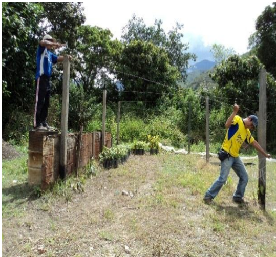
Foto 16. Construcción de vivero central en San Pedro.
