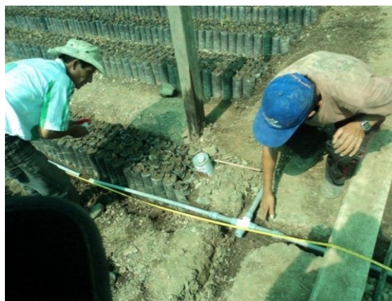
Foto 21. Instalación de sistema de riego en vivero.
