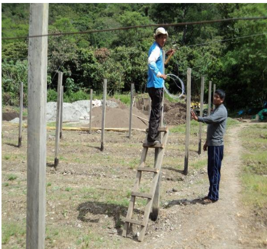
Foto 18. Tendido de alambres entre los postes.
