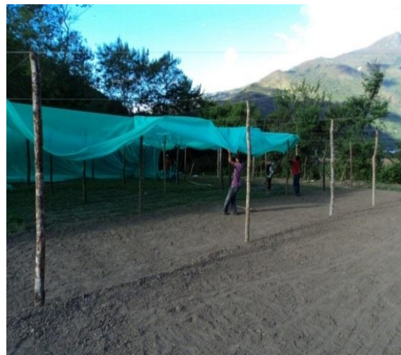
Foto 19. Tendido de malla rashell sobre el tinglado.
